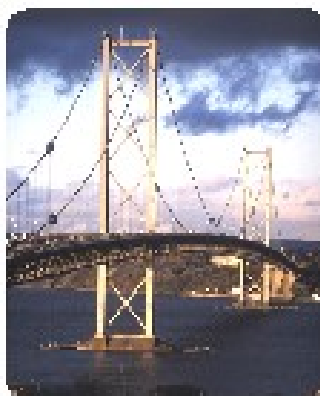
Εικόνα 2.28 Παρακολούθηση γέφυρας μέσω δεκτών Galileo
