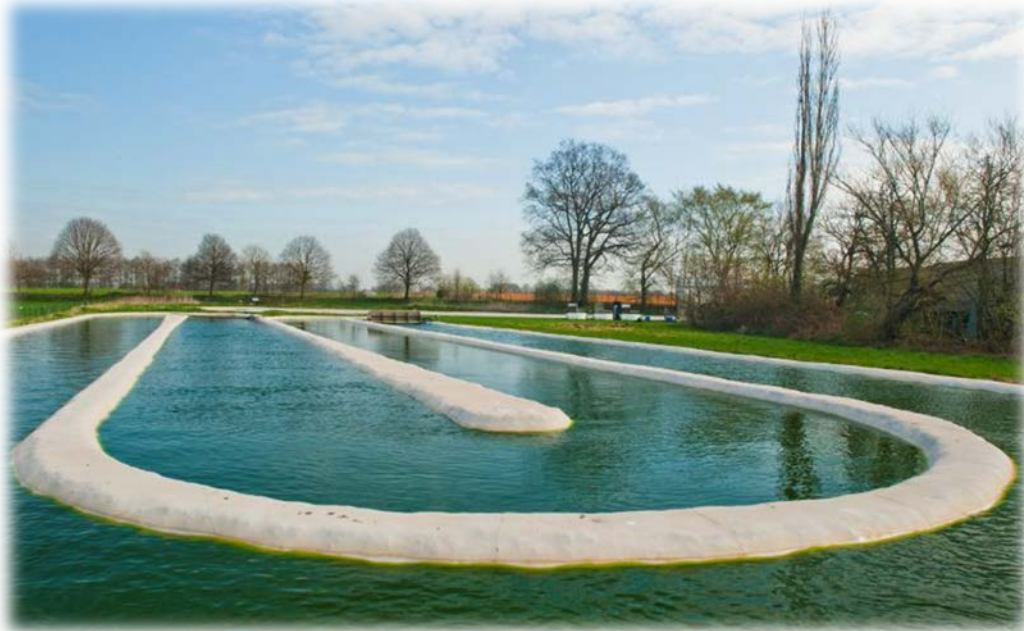
Σχήμα 2.1: Σύστημα ανοιχτής ή μακρόστενης δεξαμενής [131]
