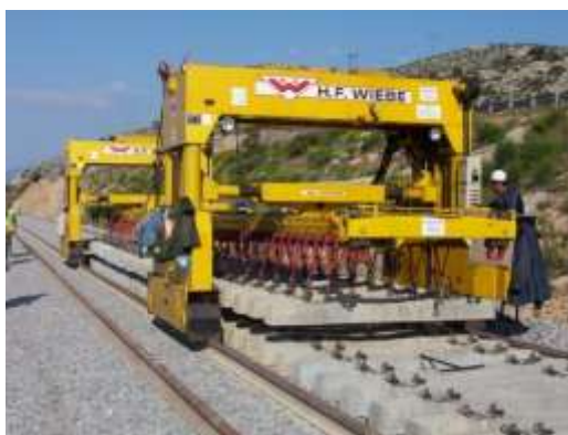
Εικόνα 2.15: Πυλώνας (εναποθέτει ένα παρά έναν στρωτήρα)
