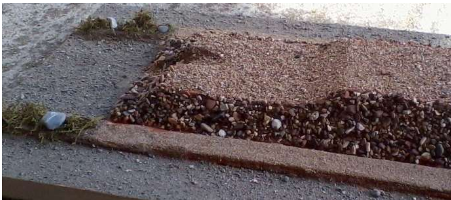
Εικόνα 4.3: Εκσκαφή φυτικών γαιών και κατασκευή επιχώματος σε στρώσεις
