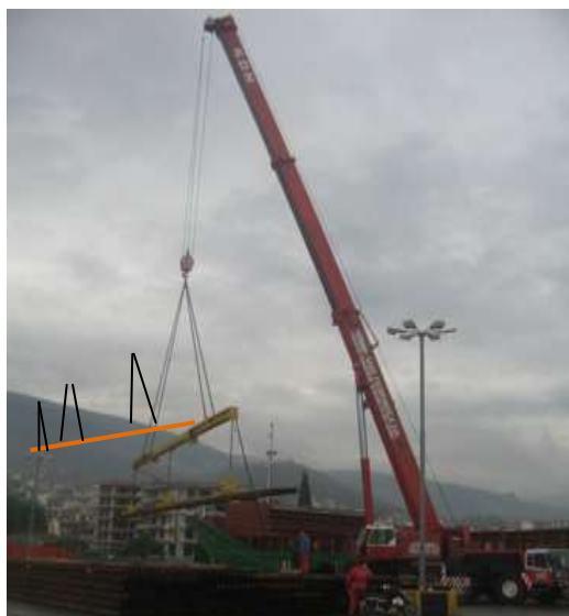
Εικόνα 2.12: Φόρτωση σιδηροτροχιών με οδικό γερανό
