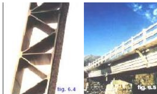
Εικόνα 1.7: Ειδική διατομή για προστατευτικές μπάρες με κράμα 6063 τοποθετούνται σε ελάχιστο χρόνο
