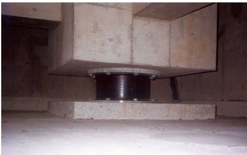
Σχήμα 3.3: Εφέδρανο LRB – Κτίριο Μουσείου Δυτικής Τέχνης (Τόκιο, Ιαπωνία)
