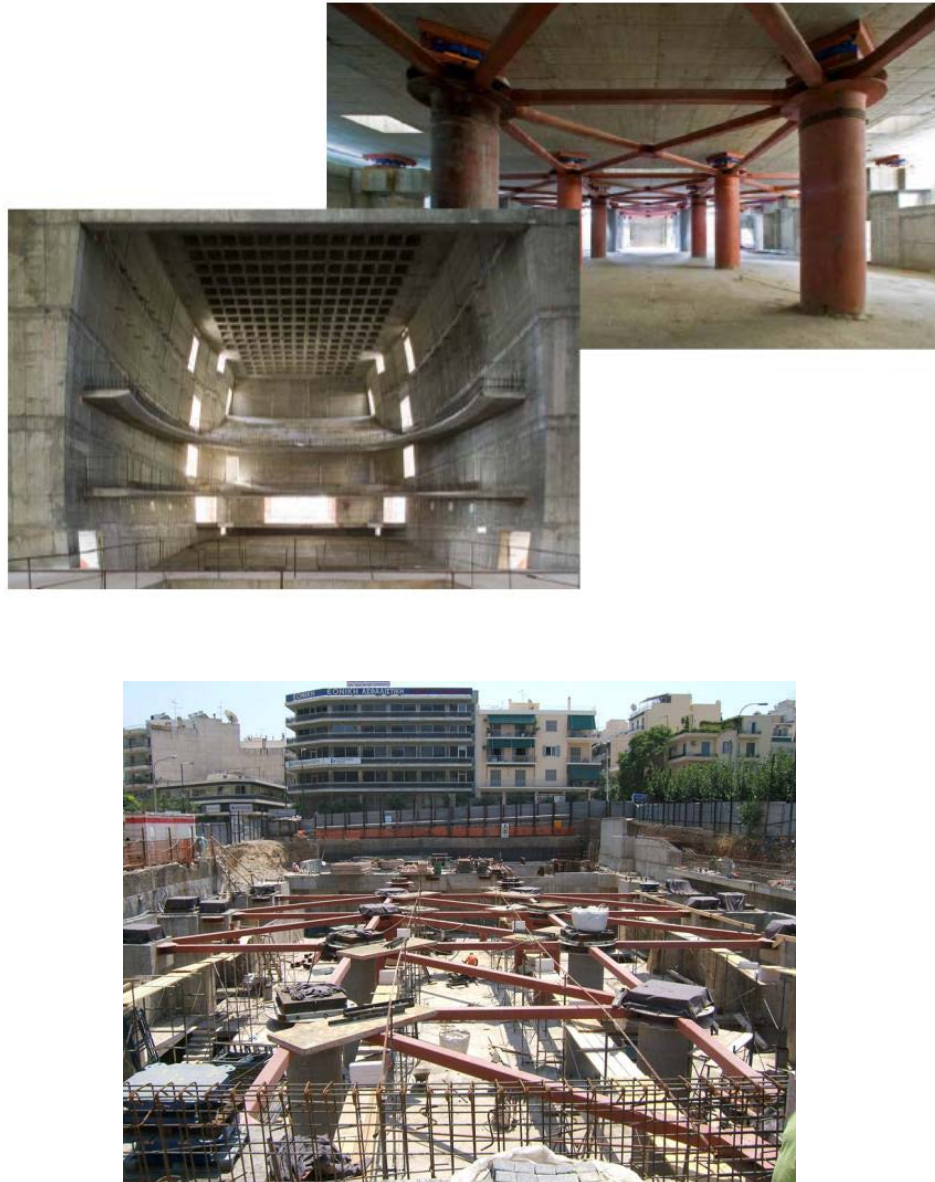
Σχήμα 3.25: Στέγη Γραμμάτων και Τεχνών του Ιδρύματος Ωνάση, Αθήνα, Ελλάδα
