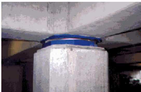
Σχήμα 3.10: Εγκατεστημένο Εφέδρανο FPS
