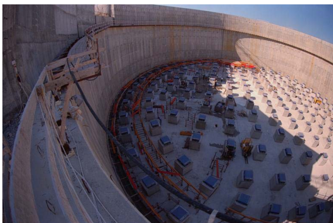
Σχήμα 3.24: Εγκατάσταση σεισμικών εφεδράνων τριβής στη Ρεβυθούσα, Ελλάδα
