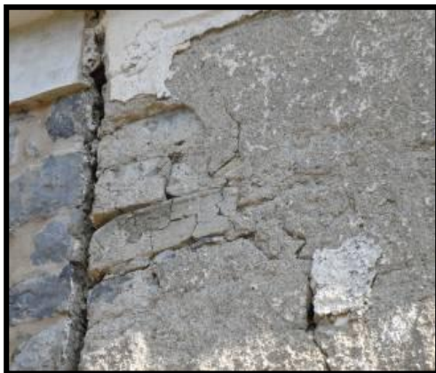
Σχήμα 6.3: Αρμός μεταξύ των γειτονικών κτιρίων
