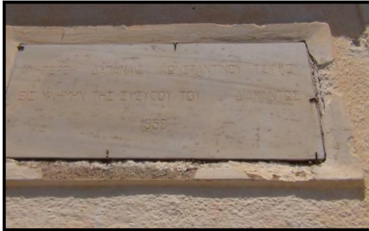
Σχήμα 6.2: Εντοιχισμένη μαρμάρινη πλακέτα στον εξωτερικό τοίχο, όπου αναγράφονται τα ονόματα των ευεργετών και το έτος αποπεράτωσης της κατασκευής
