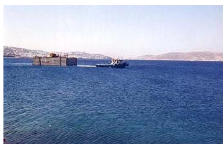
Σχήμα 25: Ρυμούλκηση Κυβελωτού Κιβωτίου προς την τελική θέση πόντισης. [Σιώρης, 1999]
