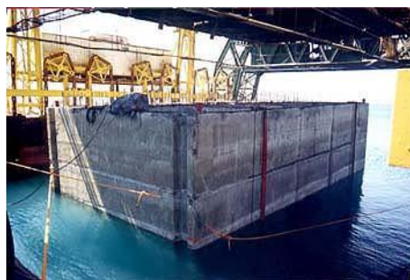
Σχήμα 24: Κυβελωτό κιβώτιο μετά το πέρας της σκυροδέτησης σε κατάσταση πλεύσης [Σιώρης, 1999]
