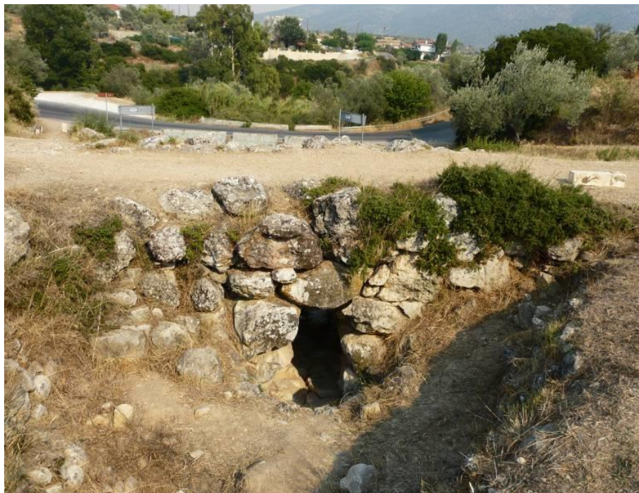
Εικόνα 1-1: Τοξωτή γέφυρα του Αρκαδικού, Αργολίδα, Ελλάδα [3]
