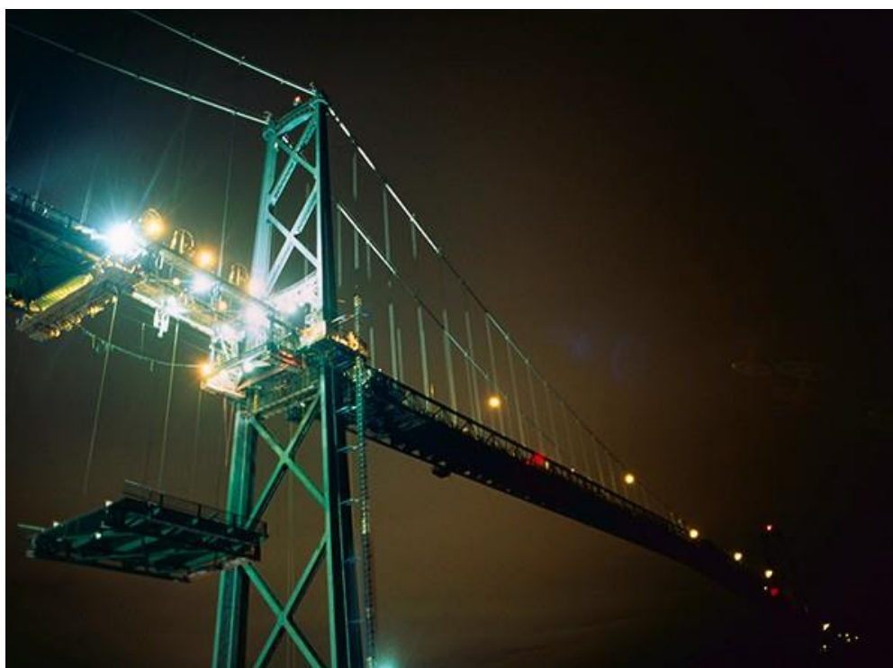
Εικόνα 3-2: 2015 Αντικατάσταση καταστρώματος (the Big Lift)
