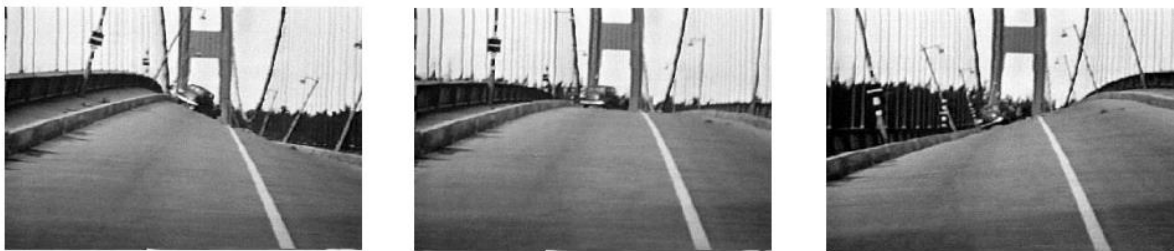
Εικόνα 5-3: Στρεπτική κίνηση γέφυρας Tacoma Narrows (1940) [104]
