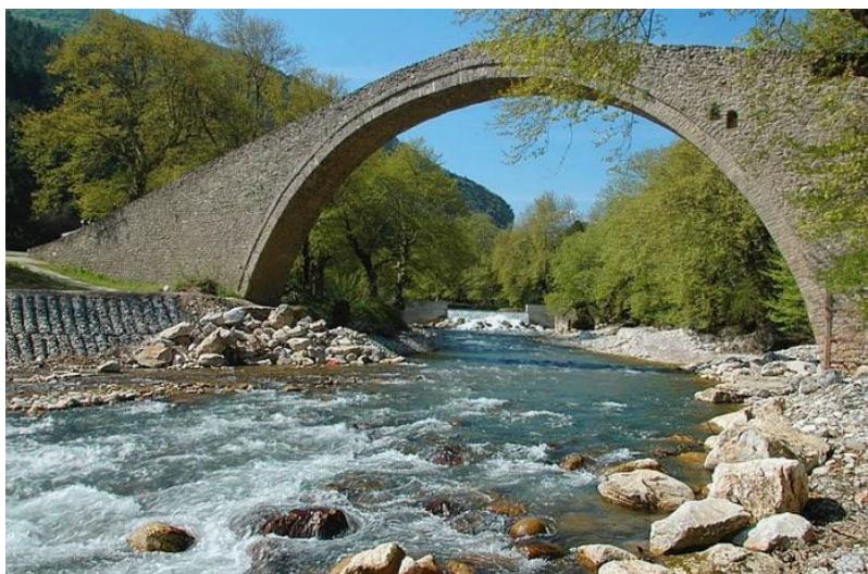
Εικόνα 1-5: Γέφυρα Αγίου Βησσαρίωνα, Τρίκαλα, Ελλάδα [10]
