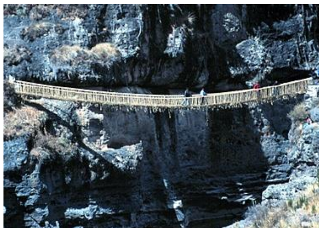
Εικόνα 1-8: Σχοινογέφυρα Queshuachaca, Canas Province, Περού [15]
