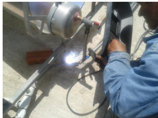
Εικόνα 5-35: Διόρθωση κλίσης μεταλλικής βάσης ηλιακού πεδίου
