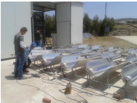
Εικόνα 5-35: Διόρθωση κλίσης μεταλλικής βάσης ηλιακού πεδίου
