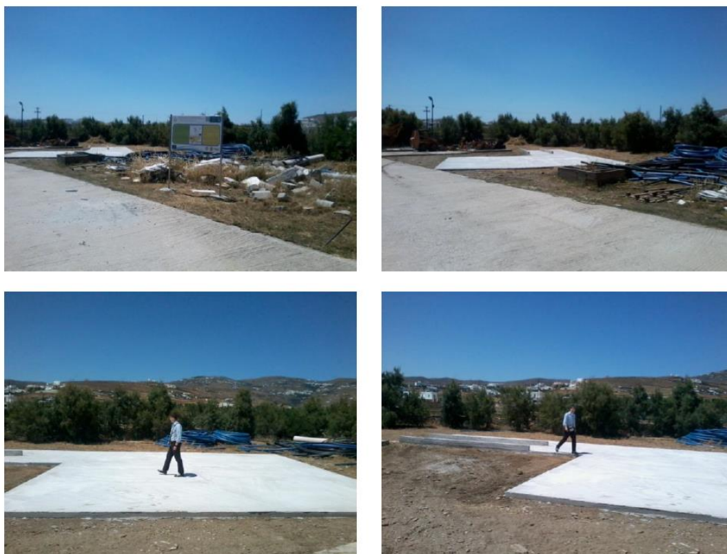
Εικόνα 5-6: Τελική άποψη πλατφόρμας σκυροδέματος
