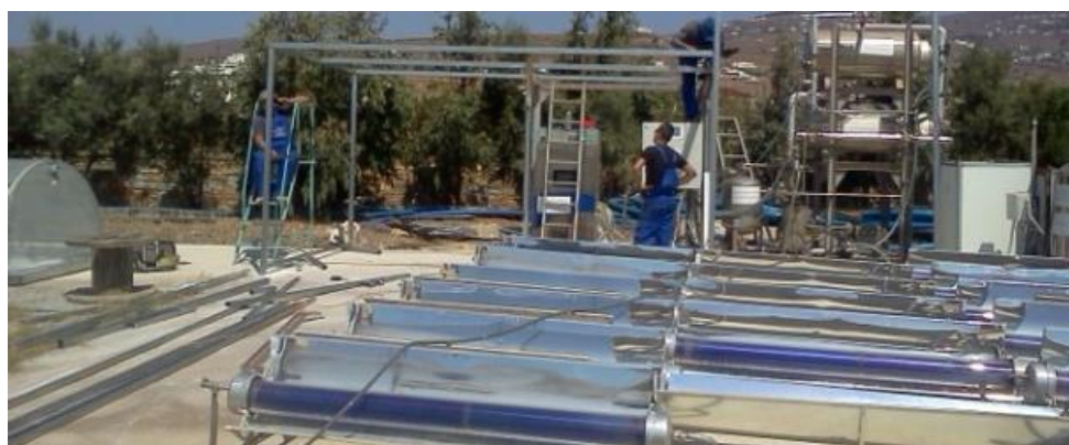
Εικόνα 5-30: Εγκατάσταση υποδομής στέγασης πιλοτικού συστήματος
