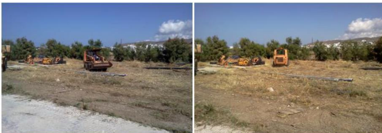
Εικόνα 5-5: Εργασίες προετοιμασίας της περιοχής εγκατάστασης του πιλοτικού συστήματος
