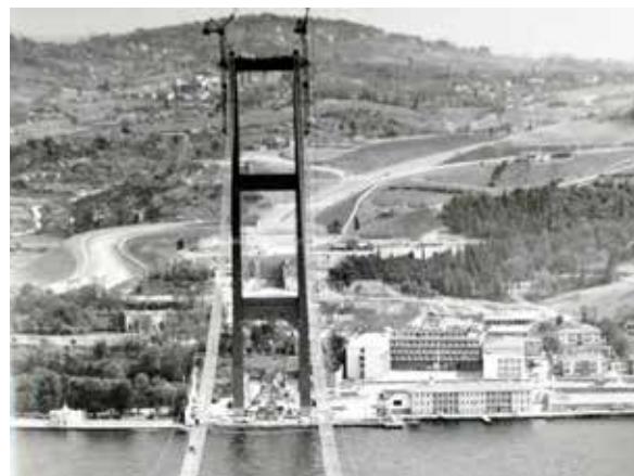
Εικ.50: Η κατασκευή της πρώτης γέφυρας του Βοσπόρου.
