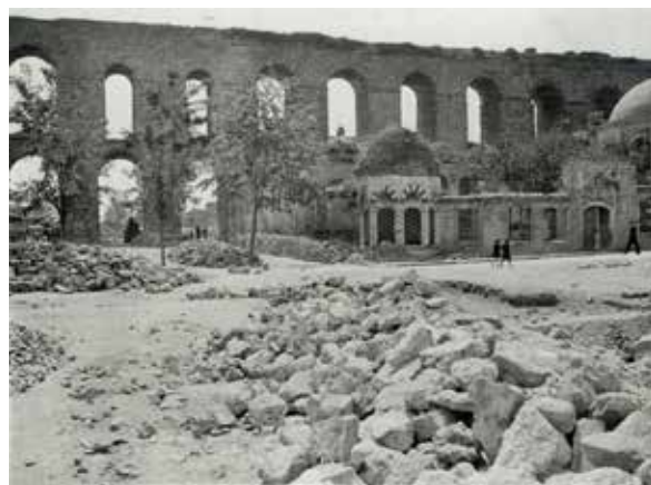
Εικ.45: Η διάνοιξη της λεωφ. Ατατούρκ στον ιστορικό ιστό.
