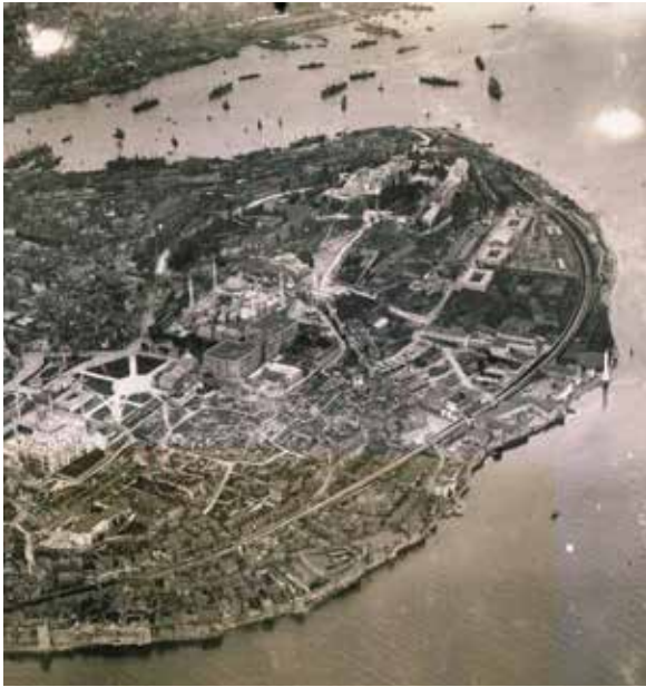
Εικ.48: Τα παραθαλάσσια βυζαντινά μνημεία και τμήματα της οχύρωσης, σε επαφή με το υγρό στοιχείο πριν την κατασκευή του νέου δρόμου.
