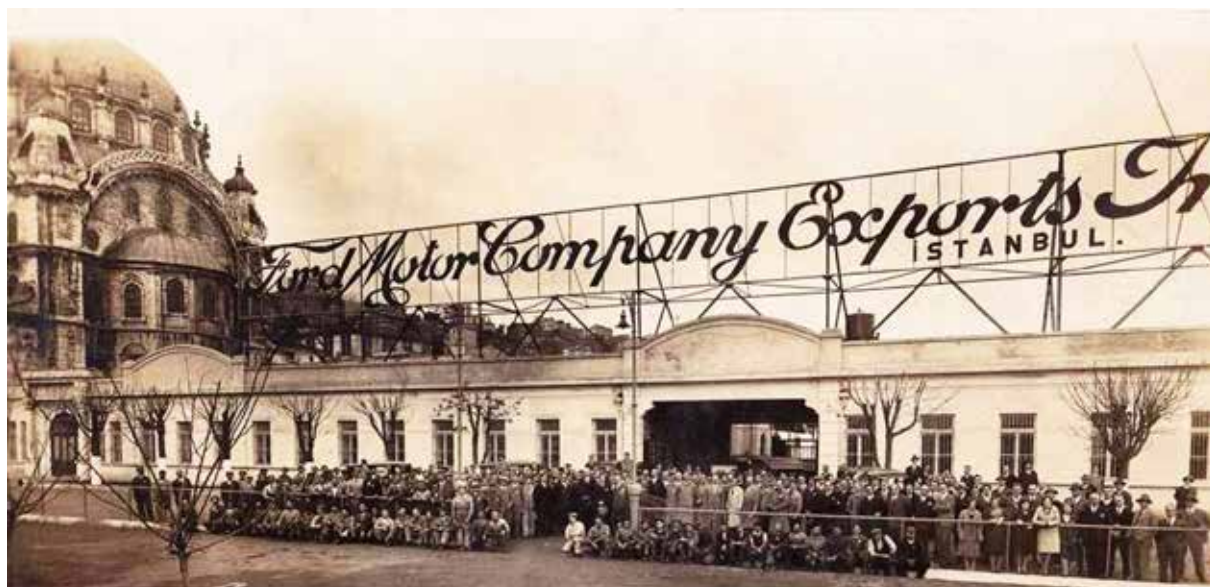
Εικ.51: Το εργοστάσιο αυτοκινήτων της αμερικάνικης εταιρείας Ford στην είσοδο του Κεράτιου κόλπου.
