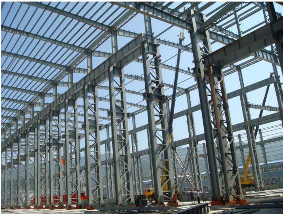
Σχ1.4 Σύνθετα υποστυλώματα με κύρια μέλη διατομής Η, με χιαστί και ορθοστάτες
