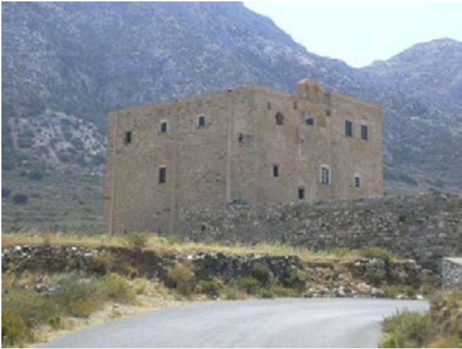
Εικόνα 96-Πύργος Μπαζαίου λίγο πριν τον οικισμό του Χαλκείου (Τραγαίας)
