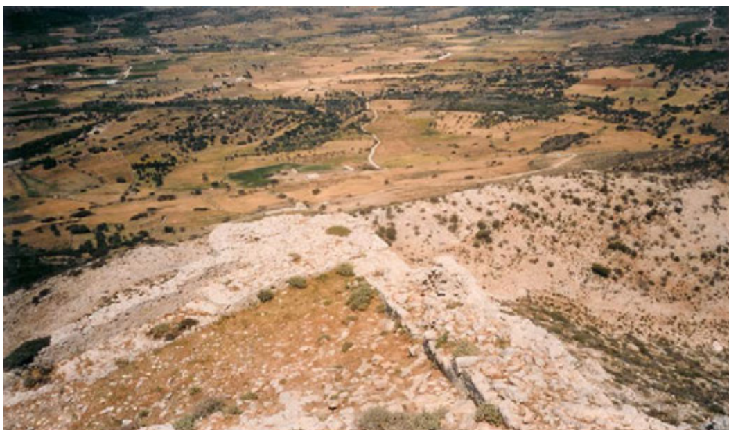
Εικόνα 78– Εξωτερικός τοίχος Κάστρου
