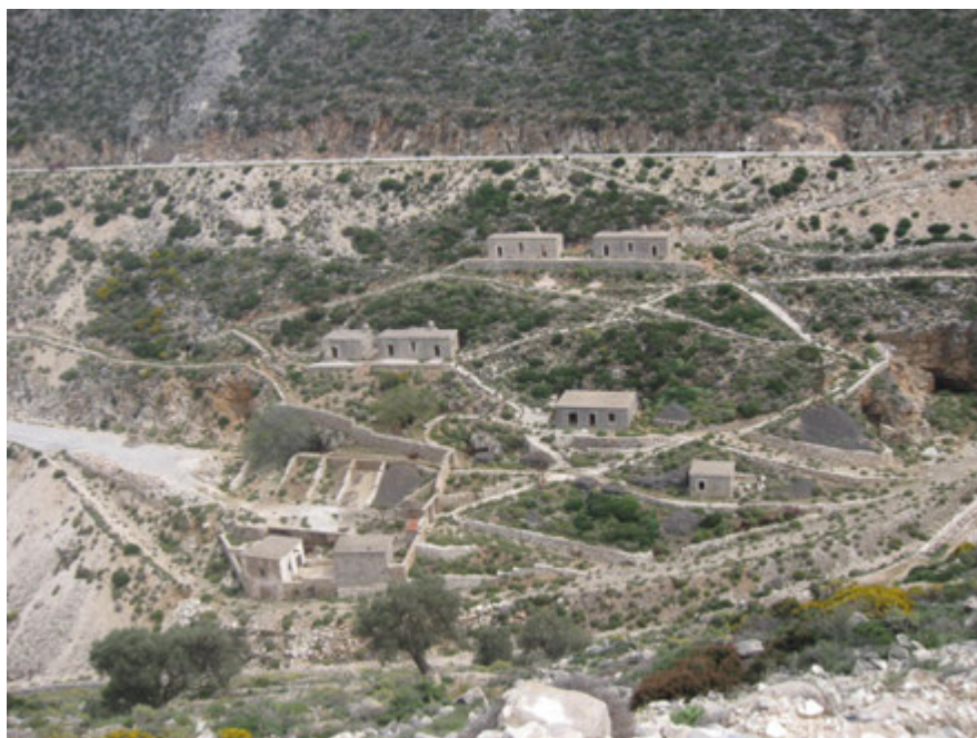
Εικόνα 51-Στραβολαγκάδα: η περιοχή του σταθμού φόρτωσης σμύριδας
