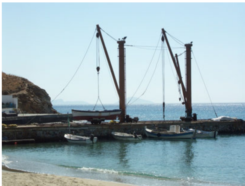
Εικόνα 50-Προβλήτα τερματικού σταθμού Μουτσούνα
