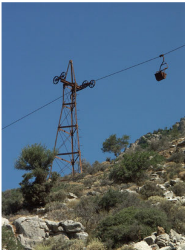
Εικόνα 49-Εναέριος σιδηρόδρομος σμύριδας
