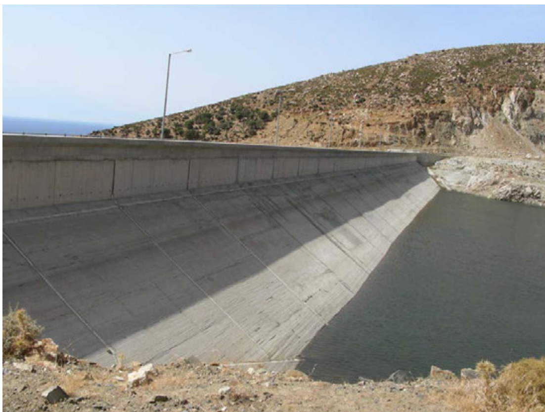
Εικόνα 21-Το Φράγμα της Φανερωμένης χωρητικότητας 1.450.000 m3
