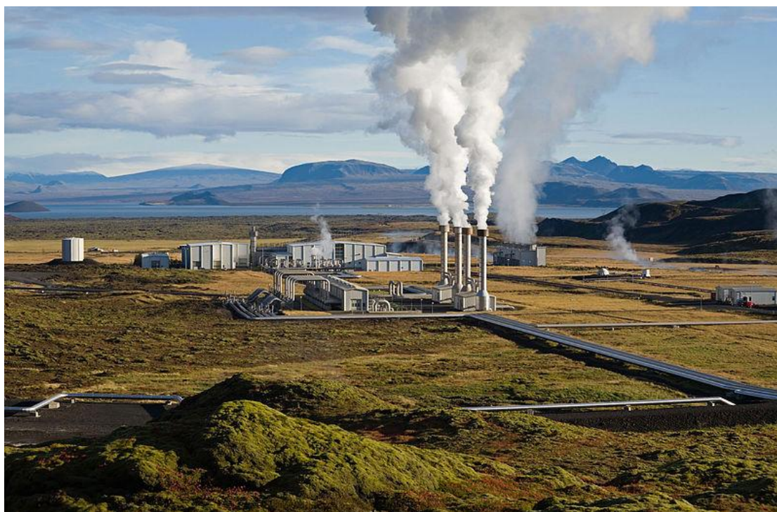
Εικόνα.16.: Το Γεωθερμικό Πάρκο Nesjavellir (120MW) Thingvellir/Ισλανδία
