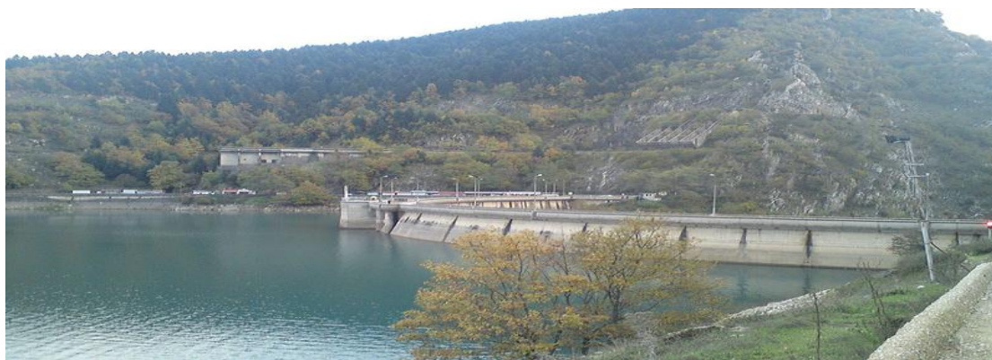
Εικόνα.11.: Το υδροηλεκτρικό φράγμα στην Λίμνη Πλαστήρα (400MW) - Καρδίτσα /Ελλάδα
