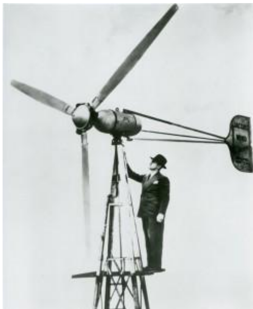
Εικόνα.8.: Μικρή Α/Γ (2,5 kW) του 1940 [Πηγή: Jacobs Wind Electric Company]
