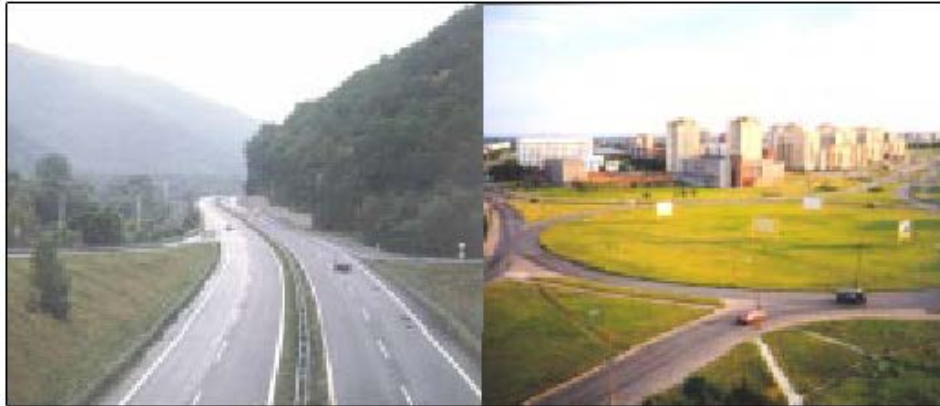
Εικόνα 1.25: Αντιπροσωπευτική εικόνα της εν λόγω κατηγορίας με παραδείγματα οδικού και σιδηροδρομικού δικτύου (Σλοβακία, Λιθουανία) (CLC manual).
