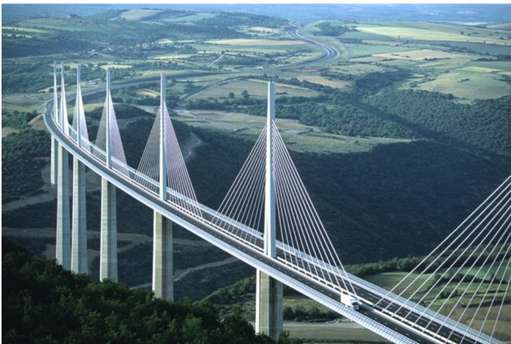
Εικόνα 10.2 Ημιακτινωτή διάταξη στη γέφυρα Millau Viaduct
