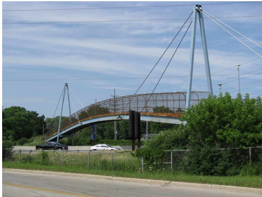
Εικόνα 1.1 Menomonee Falls pedestrian bridge
