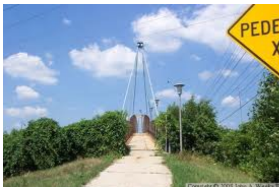
Εικόνα 1.2 Είσοδος προς την πεζογέφυρα
