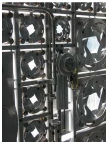
Εικόνα 4.2 - Ρυθμιζόμενα μεταλλικά διαφράγματα της όψης από έξω και από μέσα
