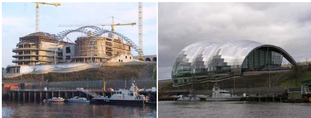
Εικόνα 4.6 - Sage Gateshead, UK. Αριστερά: κατά την κατασκευή του/ Δεξιά: Ολοκληρωμένο
