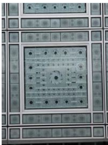
Εικόνα 4.2 - Ρυθμιζόμενα μεταλλικά διαφράγματα της όψης από έξω και από μέσα
