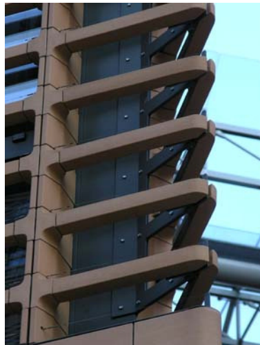
Εικόνα 4.7 –Debris Tower, Potsdamer Platz, Berlin. Αριστερά: εξωτερική άποψη/ Δεξιά: Λεπτομέρεια συναρμογών στις ενώσεις των τμημάτων
