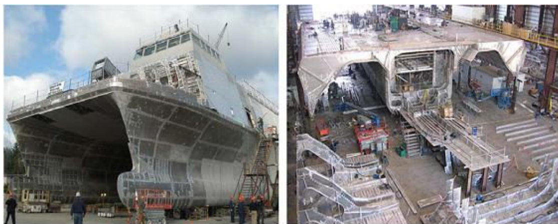
Εικόνα 2-4: Ανέγερση νέων προηγμένων τύπων πλοίων υψηλών επιδόσεων με σημαντικά διαφορετική μορφή γάστρας εξ ολοκλήρου από κράματα αλουμινίου
