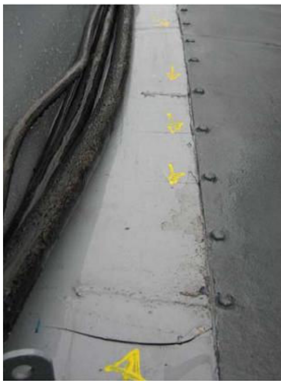
Εικόνα 2-13: Ανάπτυξη ρωγμών, λόγω των επιβαλλόμενων φορτίων στην αλουμινένια μεταλλική κατασκευή πλοίου
