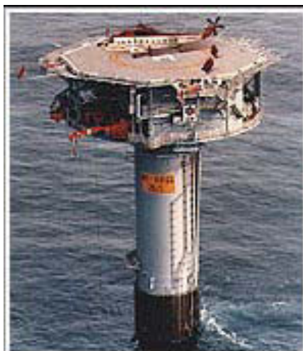
Εικόνα 2-7: Εξέδρα εξόρυξης πετρελαίου κατασκευασμένη από κράματα αλουμινίου
