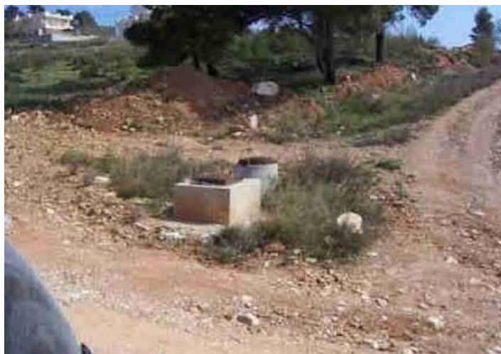
Σχήμα 2.8 Φωτογραφία από διασταύρωση οδικών αξόνων στον οικισμό του Αγ. Σπυρίδωνα.
