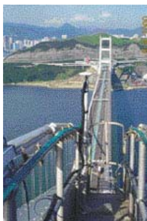
Σχήμα 2.2 Παρακολούθηση μετακινήσεων/ταλαντώσεων της γέφυρας Tsing Ma του Hong Kong με την χρήση GPS (Wong et al., 2001).Figure 2.2 Monitoting oscillation using GPS, Tsing Ma bridge-Hong kong (Wong et al., 2001).
