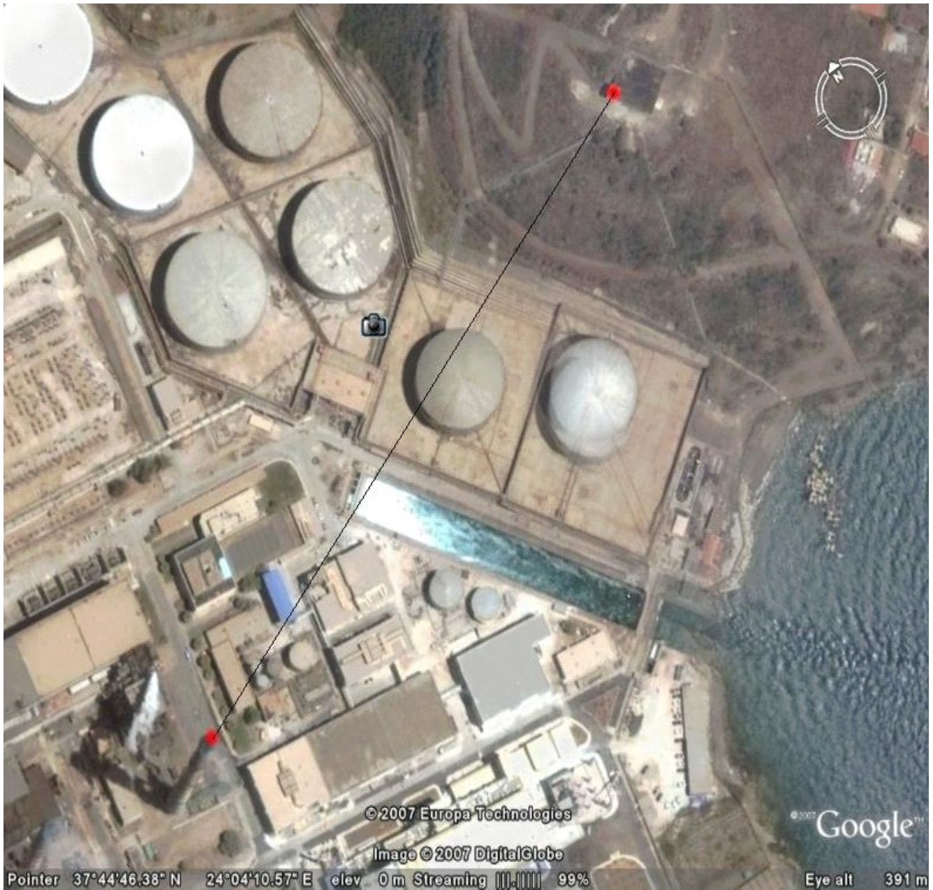
Αεροφωτογραφία τα εγκαταστάσεων του ΑΗΣ Λαυρίου, ΔΕΗ ΑΕ από όπου φαίνονται η θέση στάσης του οργάνου και η θέση του κατόπτρου, καθώς και η μεταξύ τους απόσταση.
