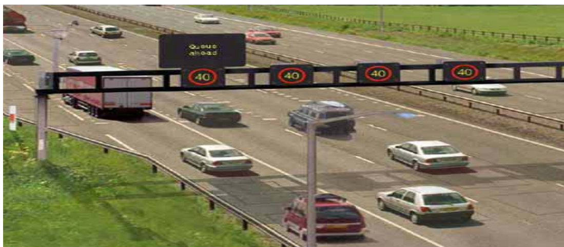
ΕΙΚΟΝΑ 1-1: ΧΡΗΣΗ VSL ΣΤΗ ΔΙΑΤΟΜΗ 3 ΤΟΥ ΑΥΤΟΚΙΝΗΤΟΔΡΟΜΟΥ M-25 (Ην. Βασίλειο)
