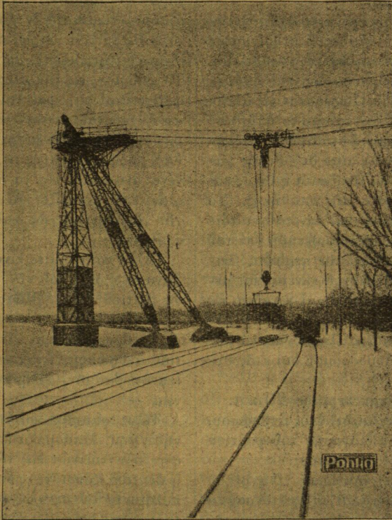
Σχ. 3. — Ἀκραῖος σταθμὸς τοῦ παλινδρομοῦ ἐναερίου τοῦ τυρφορῶντος Hesper ἐν Herpen.
