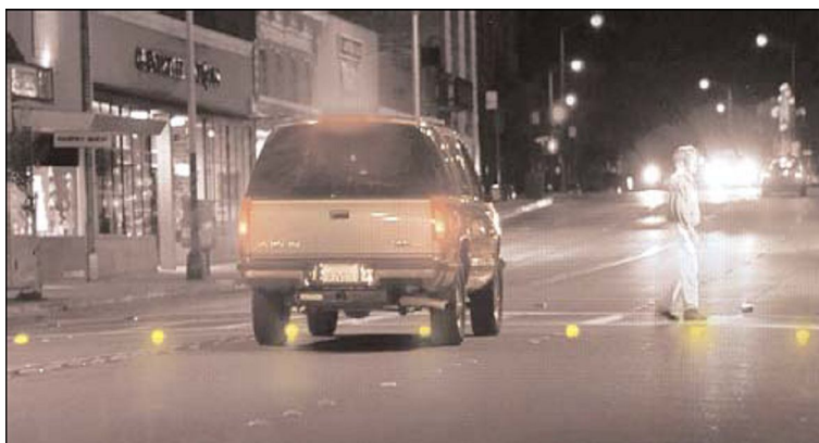
Εικόνα 3-2: Διάβαση με τοποθετημένους λαμπτήρες επ' αυτής
