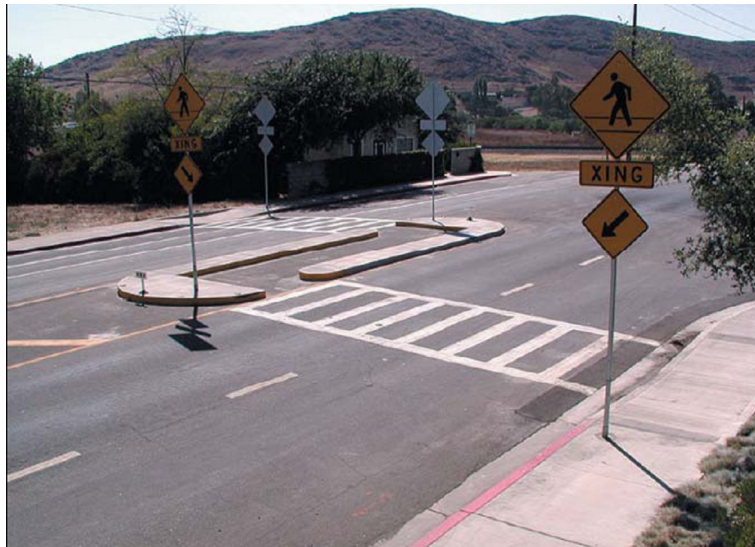
Εικόνα 2-23: Διάβαση με νησίδα στη μέση
