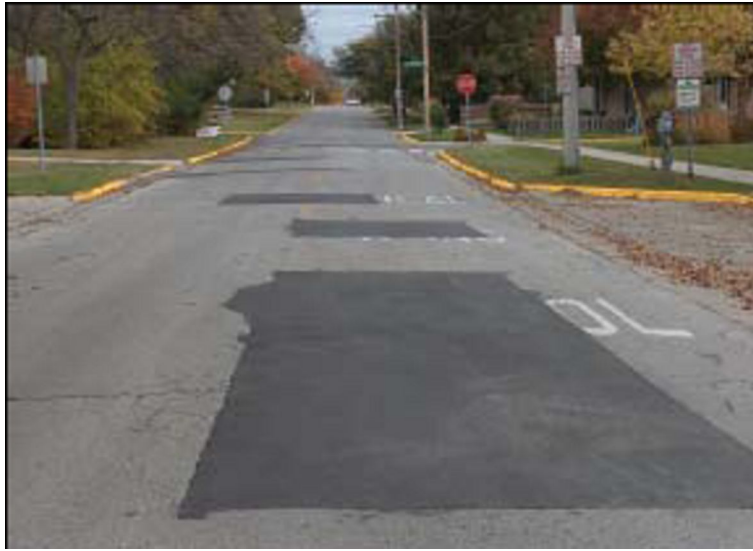
Εικόνα 1-3: Κατεστραμμένη διαγράμμιση οδοστρώματος.
