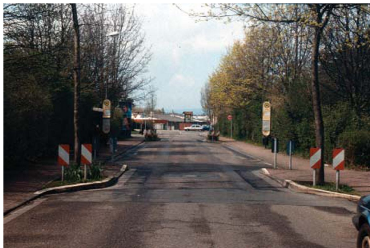
Εικόνα 2-8: Μείωση πλάτους λωρίδας
