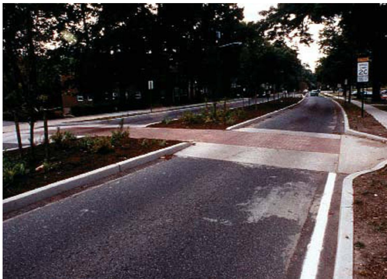
Εικόνα 2.16: Υπερύψωση οδοστρώματος σε διάβαση
