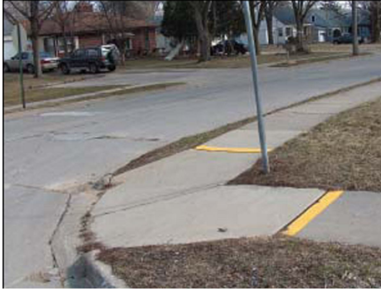
Εικόνα 2-28: Διαγράμμιση επί του πεζοδρομίου η οποία υποδεικνύει στα παιδιά σε ποιο σημείο πρέπει να σταματήσουν πριν διασχίσουν το δρόμο.
