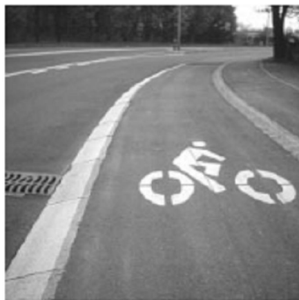
Εικόνα 2.26: Ποδηλατόδρομος ο οποίος βρίσκεται υψομετρικά χαμηλότερα από το πεζοδρόμιο και ψηλότερα από το οδόστρωμα
