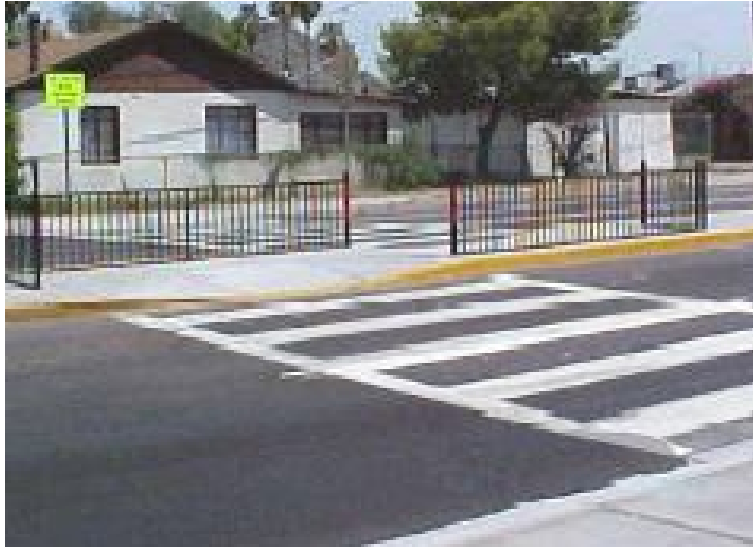
Εικόνα 4.11: Νησίδα με προστατευτικά κιγκλιδώματα
