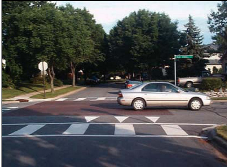
Εικόνα 2-15: Υπερύψωση οδοστρώματος σε διασταύρωση
