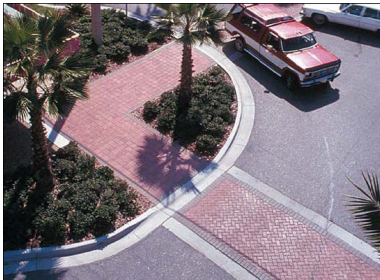
Εικόνα 2-6: Επέκταση στις γωνίες πεζοδρομίων
