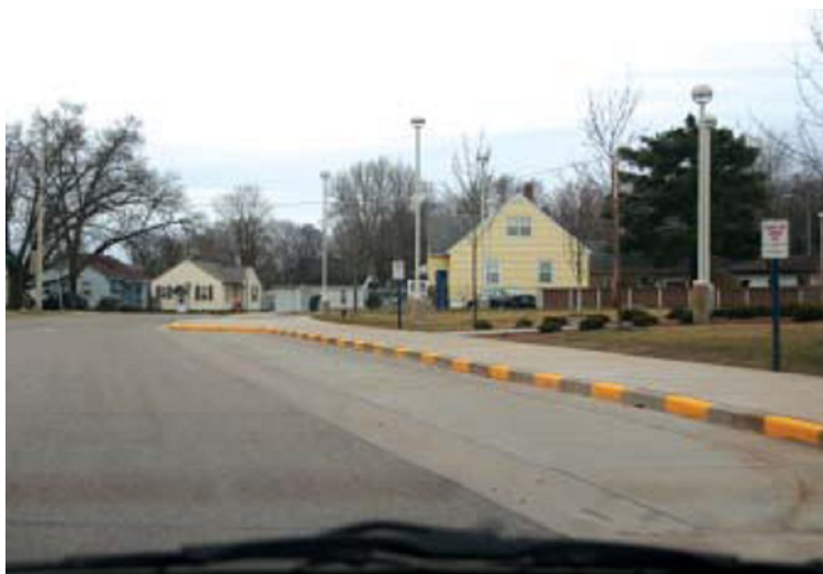
Εικόνα 2-1: Διαγράμμιση πεζοδρομίου που δηλώνει ότι απαγορεύεται η στάθμευση
