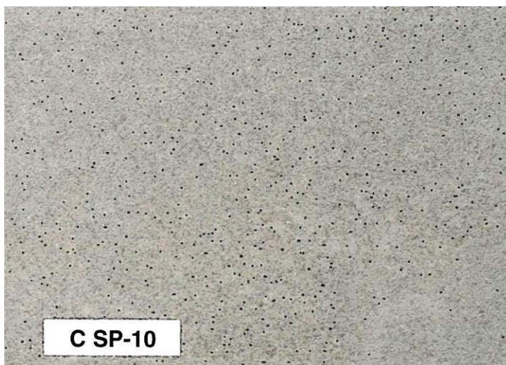
Βαθμός προετοιμασίας επιφανείας Sa 2 ½ (Σχεδόν λευκή ψηγματοβολή-Near White Metal Blast Cleaning)
