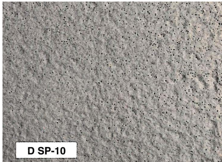
Βαθμός προετοιμασίας επιφανείας Sa 2 ½ (Σχεδόν λευκή ψηγματοβολή-Near White Metal Blast Cleaning)
