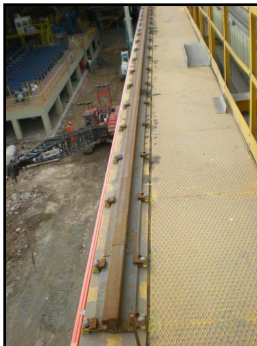
Φωτογραφία 4.2. Το δεξί τμήμα της γερανογέφυρας
