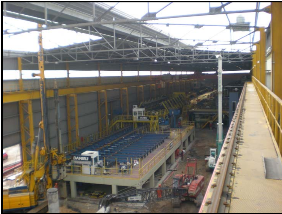
Φωτογραφία 4.1. Άποψη της γερανογέφυρας
