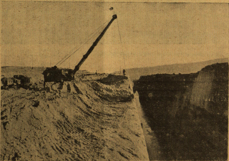
Ἐκσκαφή εἰς τὸ χεῖλος διὰ Δράγ-λαῖν τοῦ ἀμέσως κατωτέρου πηλέδου (ἐν σχέσει μετὰ τὴν ἄνω Φωτογραφίαν) (2 Ἰανουαρίου 1937)
