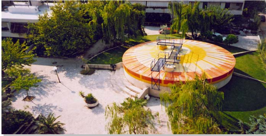
Εικόνα 3.15 Δεξαμενή νερού στο ηλιακό χωριό 3
