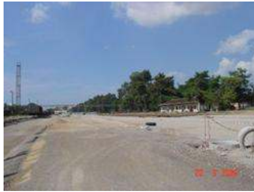
Κατασκευή πλατφόρμας προαστιακού
