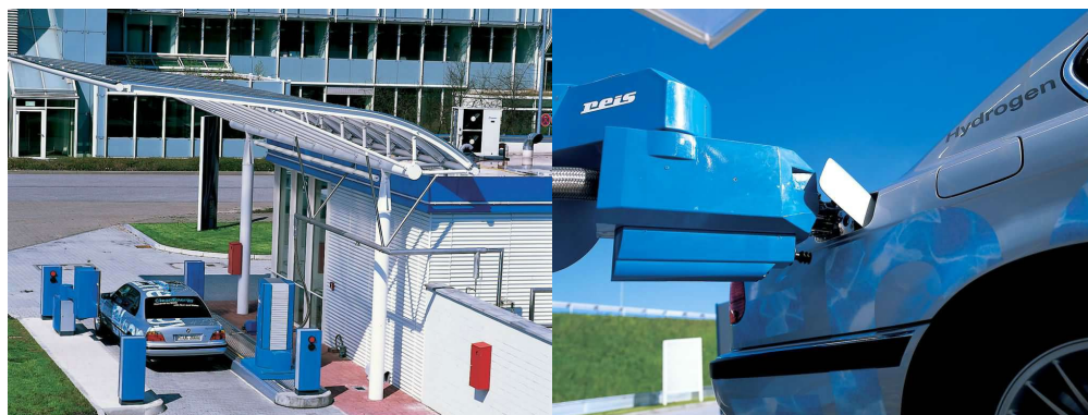
Εικόνα 5.6: Ο σταθμός ανεφοδιασμού στο αεροδρόμιο του Μονάχου και το ρομποτικό σύστημα τροφοδοσίας.
