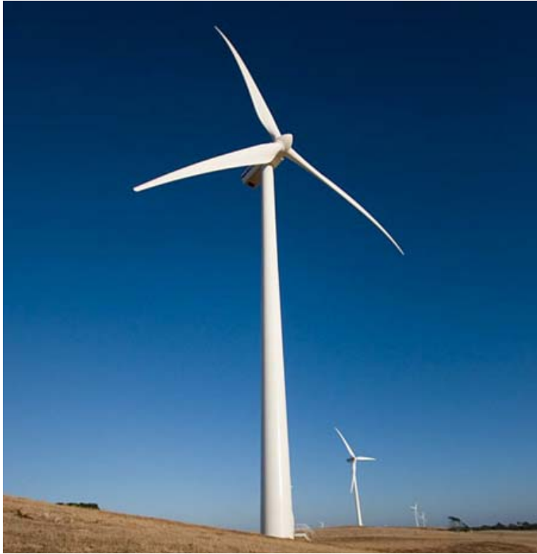
Σχήμα 4.2 : Ανεμογεννήτριες Vestas V-90,3MW ,ο τύπος των μηχανών που επιθυμείται να τοποθετηθούν στην Σέριφο [www.vestas.com]
