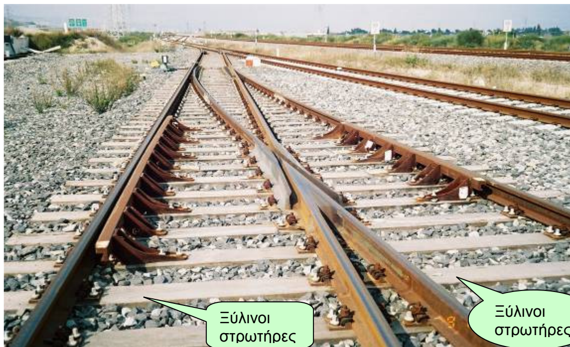
Εικόνα 14. Ξύλινοι στρωτήρες σε αλλαγή γραμμής
