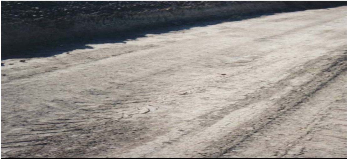
Εικόνα 28. Σταθεροποίηση με ασβέστιο
