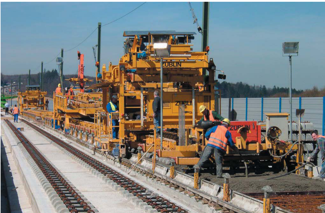
Εικόνα 46. Σταθερή επιδομή υπό κατασκευή (τύπου Züblin)
