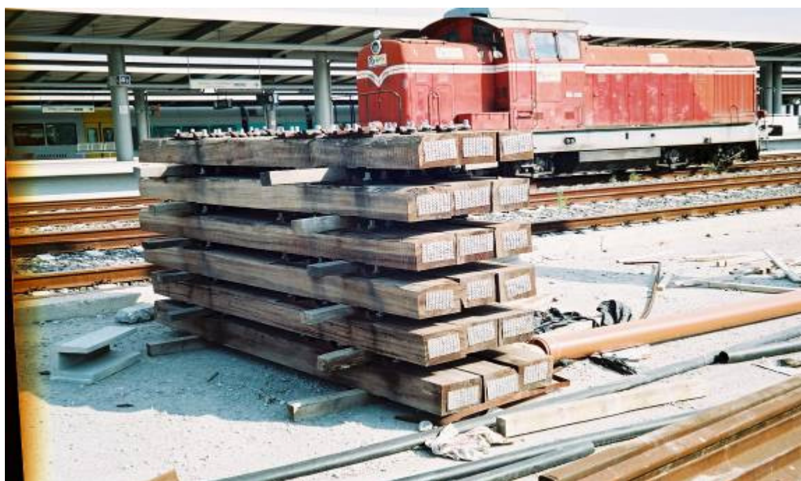
Εικόνα 15. Συσσώρευση ξύλινων στρωτήρων κατά την παραλαβή
