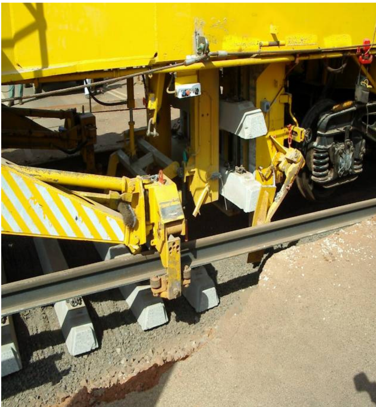
Εικόνα 50. Τοποθέτηση ολόσωμων στρωτήρων
