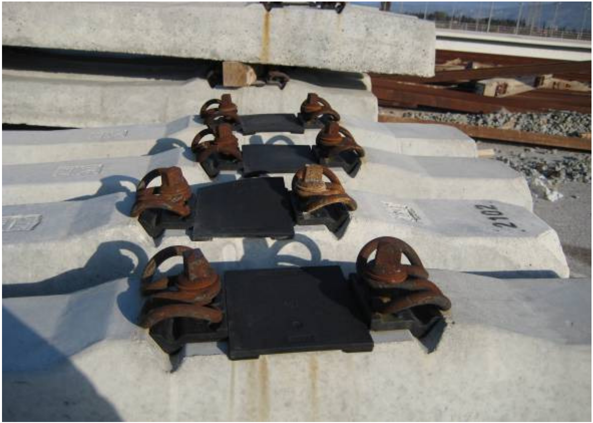
Εικόνα 10. Ελαστικοί σύνδεσμοι, στριφώνια και ελατήρια
