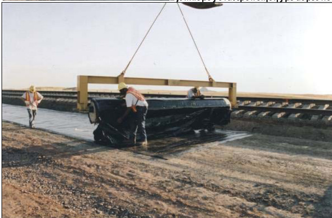
Εικόνα 27. Τοποθέτηση βιτουμενιούχας γεωμεμβράνης
