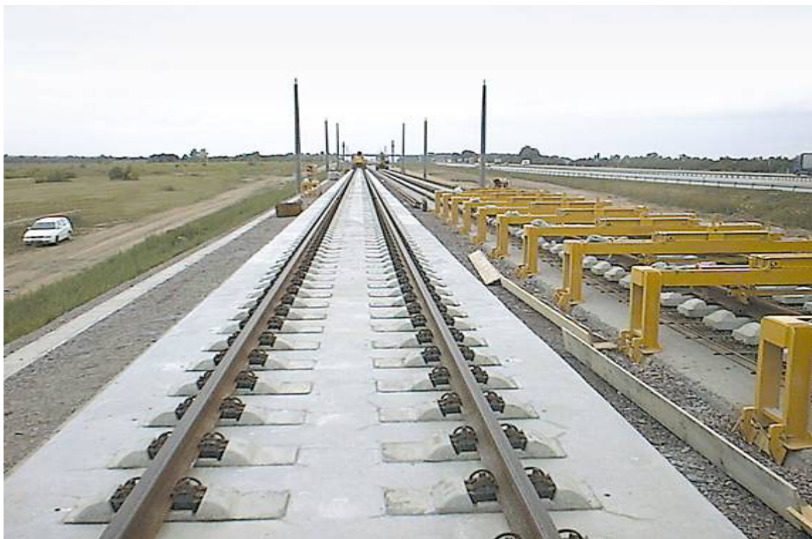
Εικόνα 47. Σταθερή επιδομή σε ημιτελές και ολοκληρωμένο στάδιο (Rheda)
