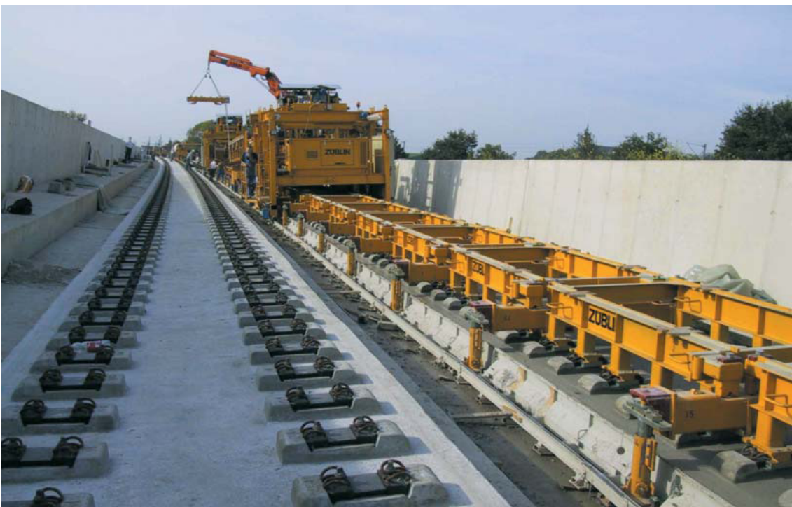
Εικόνα 44. Κατασκευή σταθερής επιδομής (τύπου Züblin)
