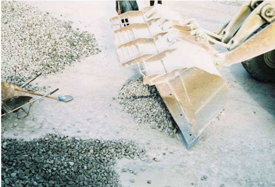
Εικόνα 96. Δεύτερος τεμαχισμός εγκάρσια στον προηγούμενο με τη βοήθεια του φορτωτή.
