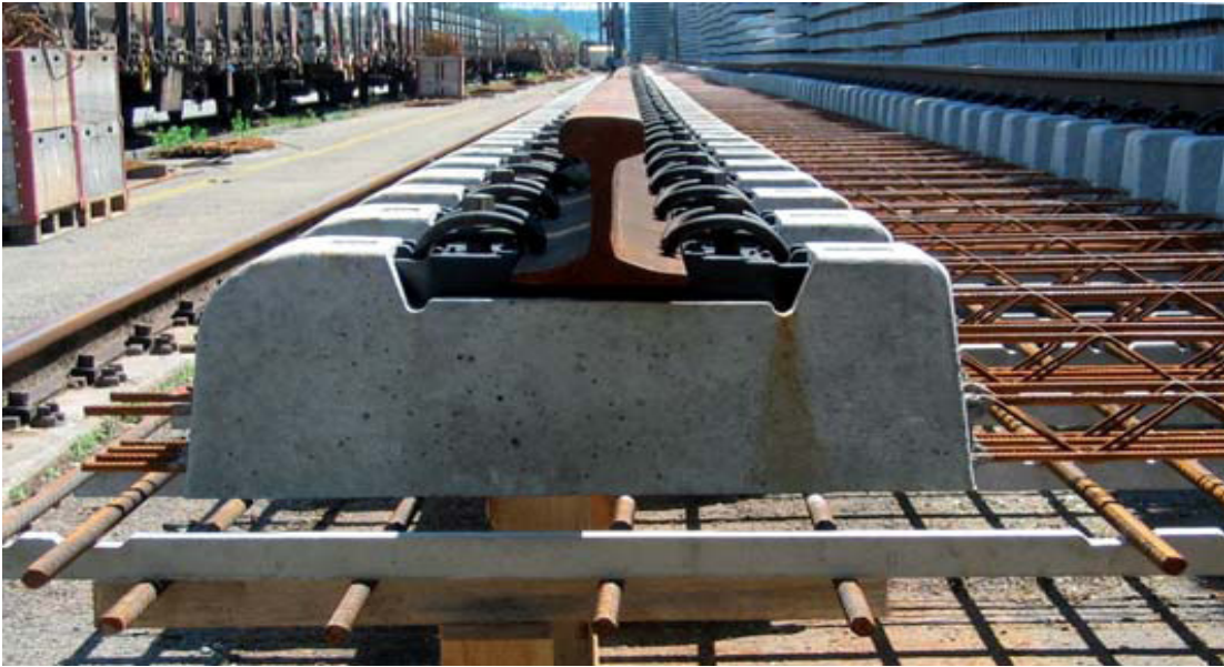
Εικόνα 43. Προφίλ μαξιλαροειδούς στρωτήρα σε υπό κατασκευή σταθερή επιδομή τύπου Züblin.
