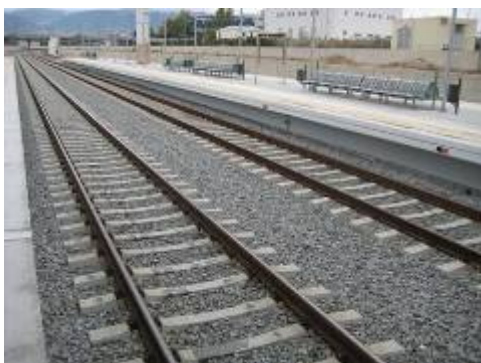
Νέα Διπλή Σιδ/κή Γρ. Υψηλών Ταχυτήτων Εικόνα 52
