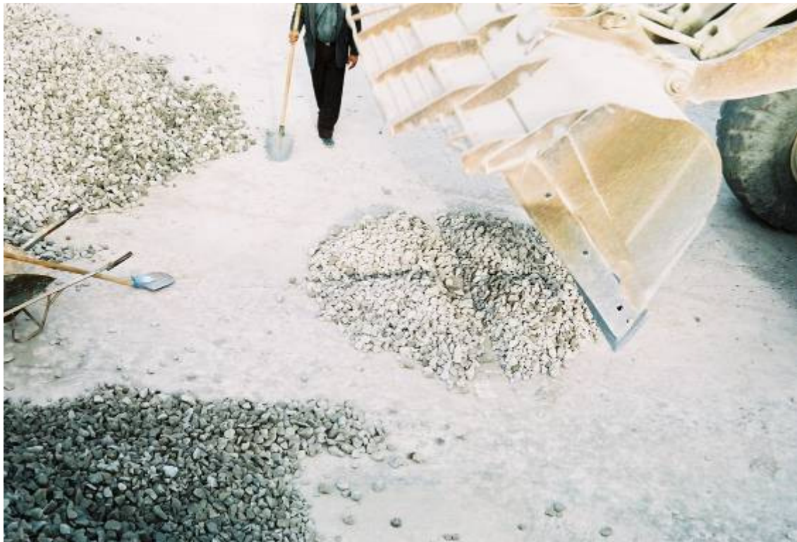
Εικόνα 97. Ολοκλήρωση του τετραμερισμού (απομάκρυνση του φορτωτή).
