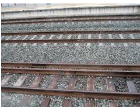
Εικόνα 55 Γραμμή Μικτού εύρους και ανεξάρτητη σιδηροδρομική Γραμμή δίπλα (Σταθμός Κιάτου)
