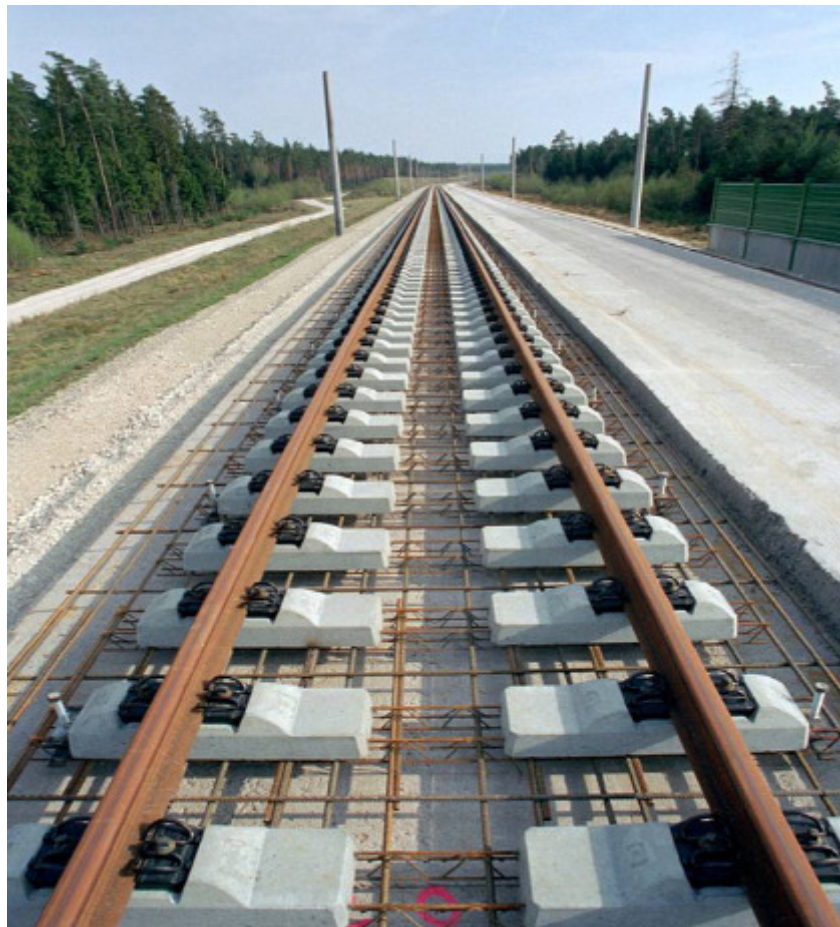
Εικόνα 42. Σταθερή επιδομή τύπου Rheda υπό κατασκευή
