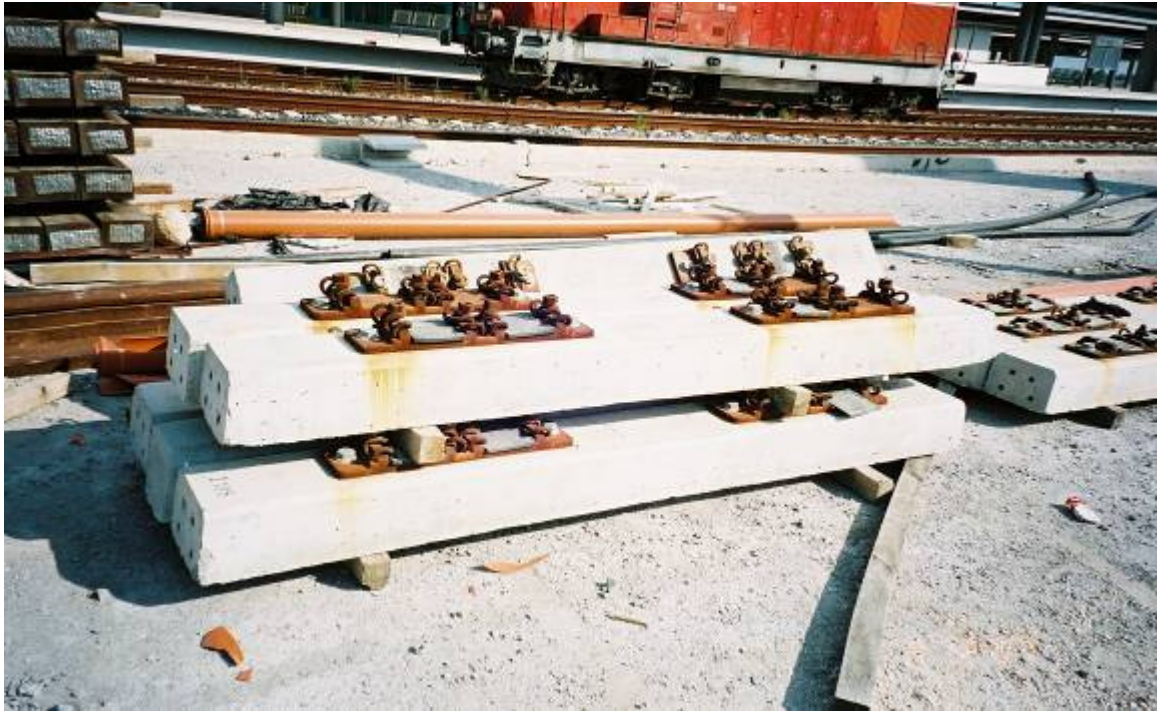
Εικόνα 16. Ενισχυμένοι στρωτήρες για «κόντρα ράγια»
