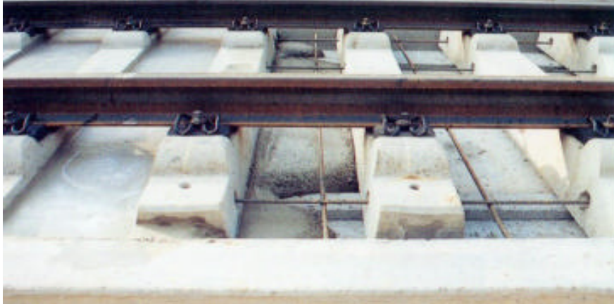
Εικόνα 38. Σκυροδέτηση σταθερής επιδομής τύπου Rheda (Γερμανία)
