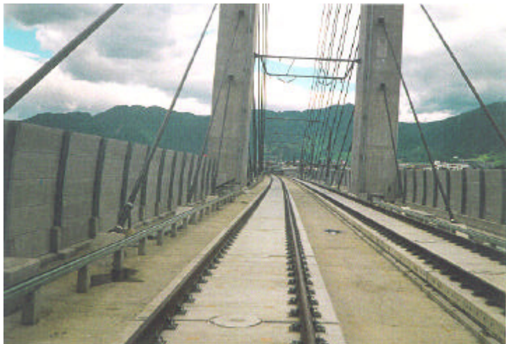
Εικόνα 40. Σταθερή επιδομή τύπου Shinkansen στην Ιαπωνία
