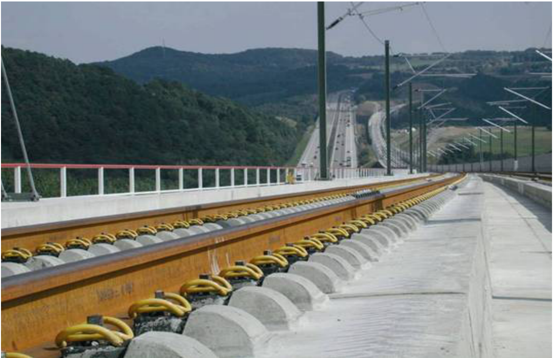
Εικόνα 45. Σταθερής επιδομή (τύπου Züblin)
