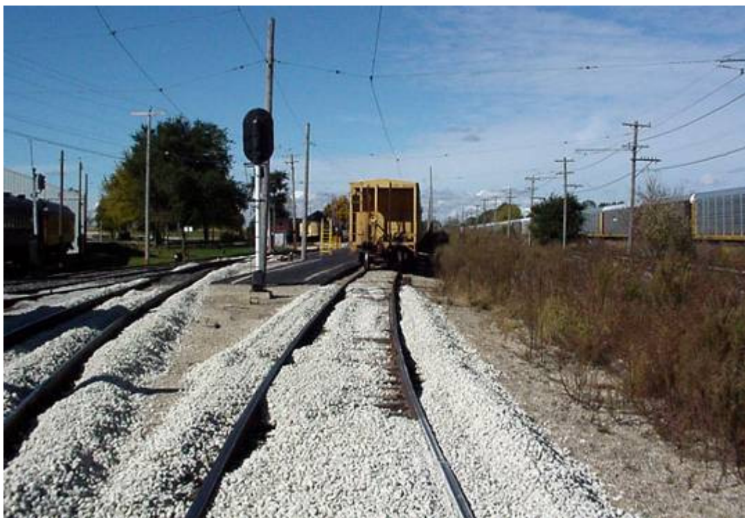
Εικόνα 51. Εργασίες σκυρόστρωσης
