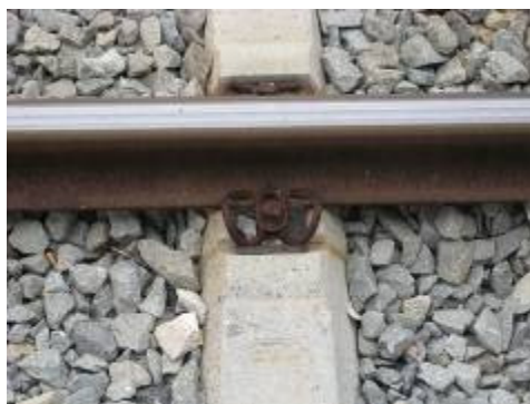
Επίδεση σιδηροτροχιάς με το στρωτήρα Εικόνα 53
