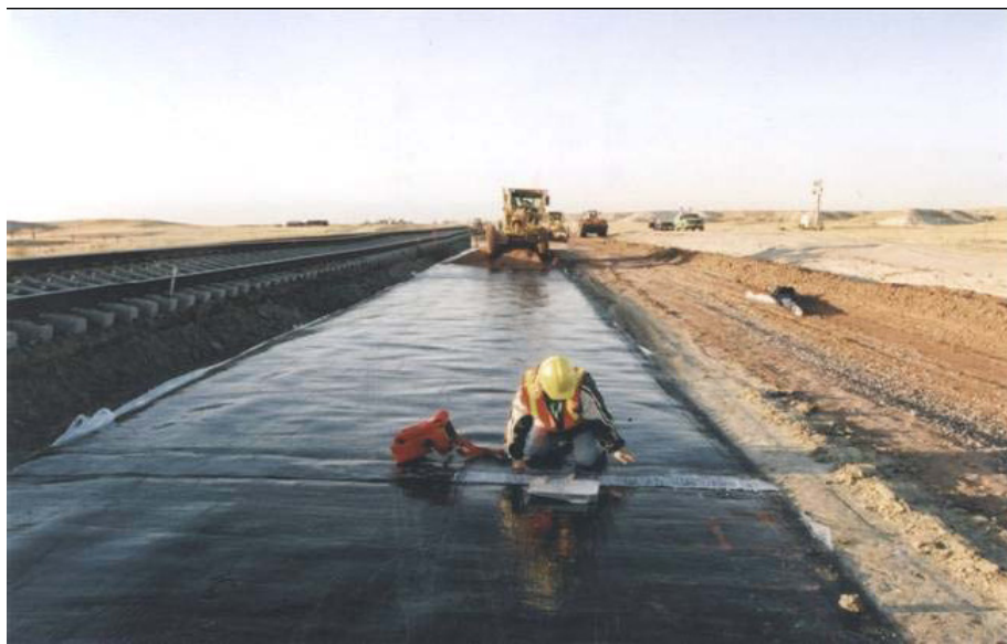
Εικόνα 30. Τοποθέτηση βιτουμενιούχας γεωμεμβράνης
