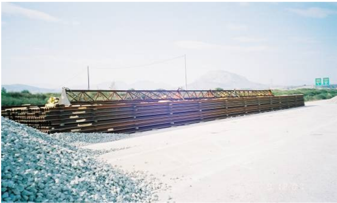
Εικόνα 7. Σιδηροτροχιές βάρους 60 kg/m σε όψη μήκους 18 μέτρων
