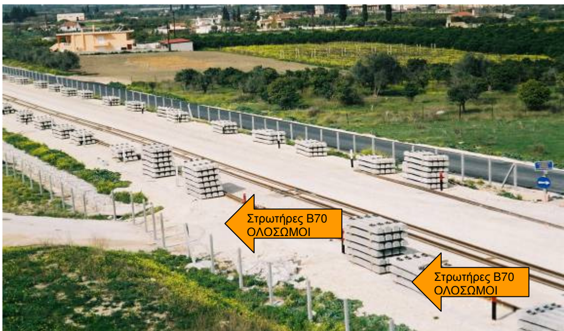
Εικόνα 17. Συσσώρευση ολόσωμων στρωτήρων δίπλα στην υπό κατασκευή νέα γραμμή (Κόρινθος – Κιάτο)
