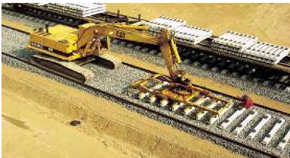
Εικόνα 49. Τοποθέτηση στρωτήρων μετά την προσκυρόστρωση
