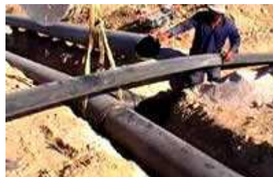
Εικόνες 22 και 23. Σύνδεση αγωγών συλλογής βιο-αερίου από HDPE
