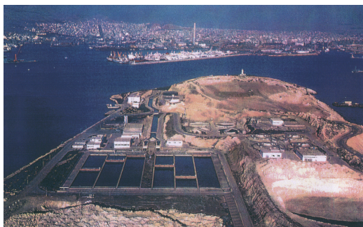
Εικόνα 29. Μονάδα επεξεργασίας λυμάτων στη Ψυτάλλεια (Πηγή: ΕΥΔΑΠ)
