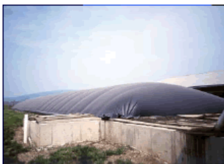
Εικόνα 18. Χωνευτήρας βιομάζας ( www.biofuels.gr )
