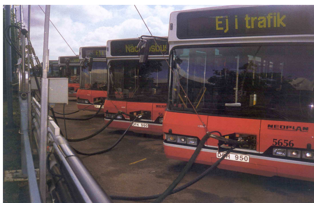
Εικόνα 26. Σταθμός διανομής βιοαερίου στη Σουηδία(Πηγή: X. Ζαφείρης, ΚΑΠΕ)
