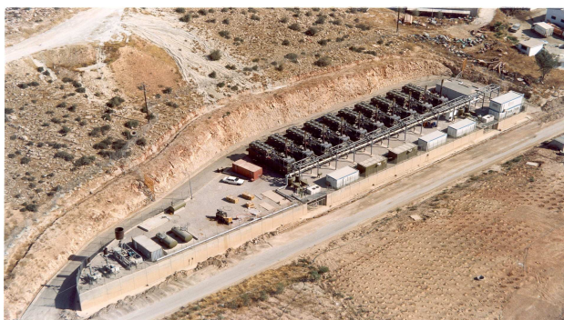
Εικόνα 28. Σταθμός ηλεκτροπαραγωγής με καύση βιοαερίου στα Α. Λιόσια
