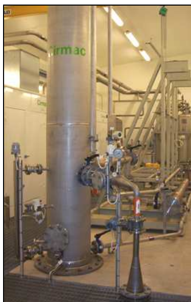
Εικόνα 17. Αναβάθμιση βιοαερίου με χημική απορρόφηση (Πηγή: X. Ζαφείρης, ΚΑΠΕ)
