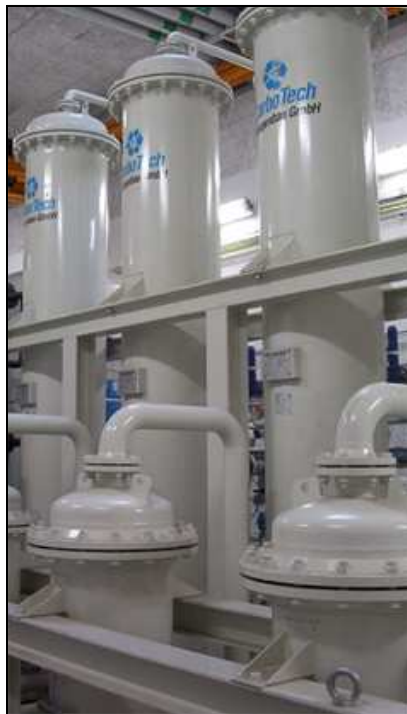
Εικόνα 15. Αναβάθμιση βιοαερίου με PSA (Πηγή: X. Ζαφείρης, ΚΑΠΕ)
