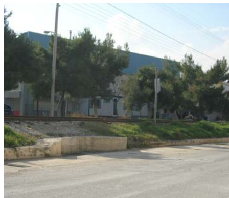
Εικόνα 12: Ανισόπεδη σιδηροδρομική γραμμή
