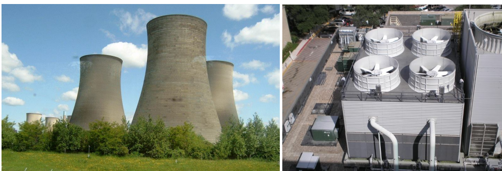
Εικόνα 5-22 : Πύργος ψύξης φυσικής κυκλοφορίας του ατμοηλεκτρικού σταθμού Didcot A Power Station Μ. Βρετανία (αριστερά) και πύργος ψύξης εξαναγκασμένης κυκλοφορίας Evartech (δεξιά)
