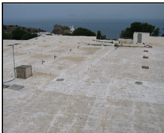
Εικόνα 5.5: Κεντρική δεξαμενή αποθήκευσης νερού.
