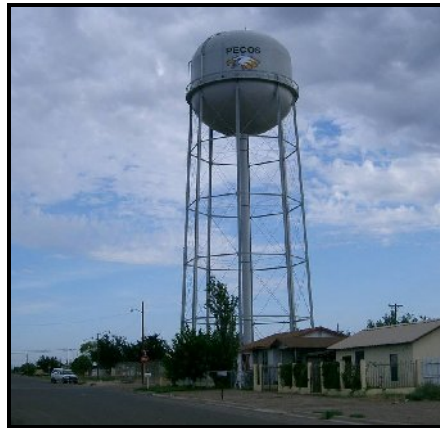
Εικόνα 4.5 : Υπέργεια δεξαμενή (υδατόπυργος)
