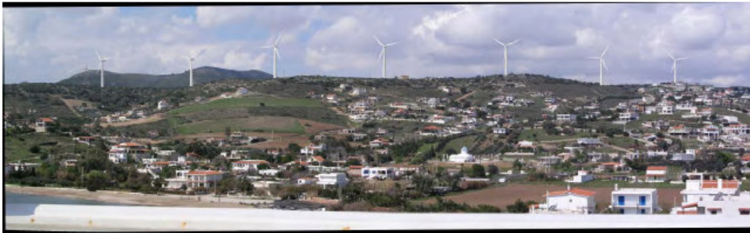
1. Αιολικό πάρκο ισχύος 5,95 MW με 7 Α/Γ 850 KW με ρότορα 52m σε απόσταση 1.200m από παρατηρητή (κάλυψη εδάφους: 7 \times 46,4 = 324,8 στρέμματα)
