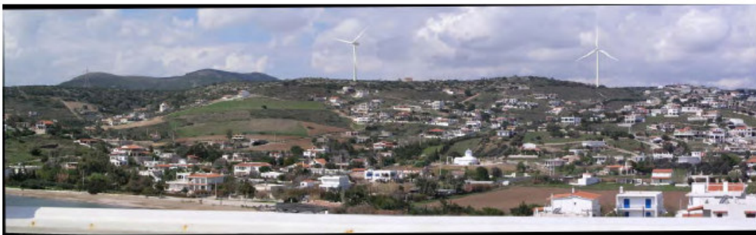
3. Αιολικό πάρκο ισχύος 6,0 MW με 2 Α/Γ 3000 KW με ρότορα 90m σε απόσταση από 1.200m παρατηρητή (κάλυψη εδάφους: 2 \times 80,32 = 160,64 στρέμματα)
