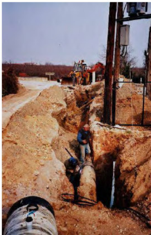
Τοποθέτηση αγωγού προσαγωγής στην άκρη επαρχιακής οδοποιίας, εντός ορρύγματος (Πρίν και Μετά τον ενταφιασμό του αγωγού) σε ΜΥΗΕ.
