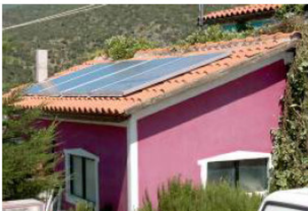
Εφαρμογή φωτοβολταϊκών σε κεραμοσκεπή εξοχικής κατοικίας
