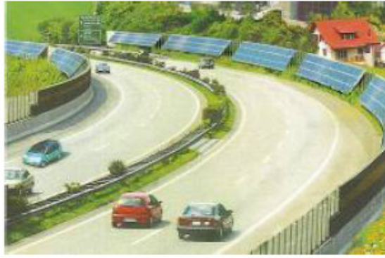
Εφαρμογή φωτοβολταϊκών σε ρόλο ηχοφράγματος σε αυτοκινητοδρόμους
