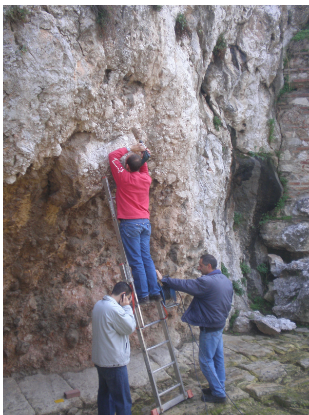
Εικόνα 16 – Υλοποίηση ενός σημείου ελέγχου του δικτύου, πάνω σε βράχο, από τον υπεύθυνο συντηρητή του χώρου
