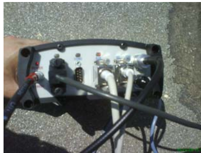
Εικόνα 5.15 : Άποψη της συνδεσμολογίας του συστήματος SPAN κατά την δοκιμή
