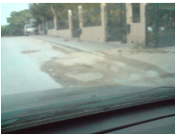
Εικόνες 12 –13 : Κατεστραμμένο Οδόστρωμα – Περιοχή Μελέτης
