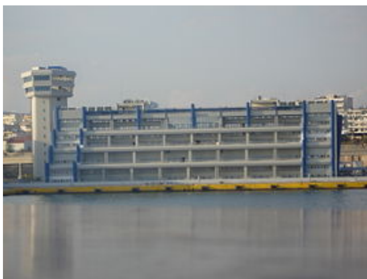
Εικόνα 7.1 κτίριο YENANΠ στην ακτή Βασιλειάδη Πηγή www.wikipedia.com
