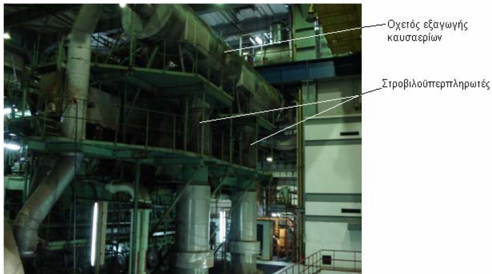
Φωτογραφία 2.2 : Όψη του ζεύγους των στροβιλοϋπερπληρωτών
