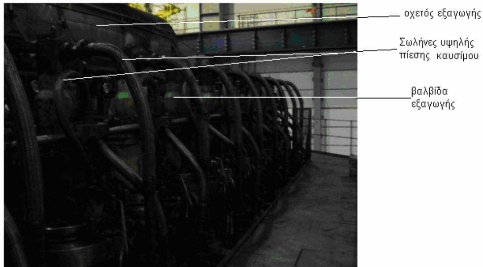
Φωτογραφία 2.1 : Κυλινδροκεφαλές του κινητήρα
