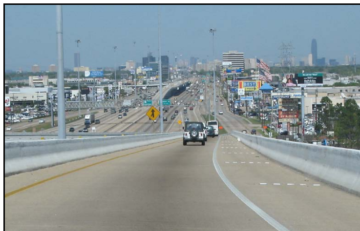
Εικόνα 2, 3 και 4: Χαρακτηριστικά Παραδείγματα Αυτοκινητοδρόμων (Αττική Οδός - είσοδος 15 Παλλήνη, Η.Π.Α., Houston
