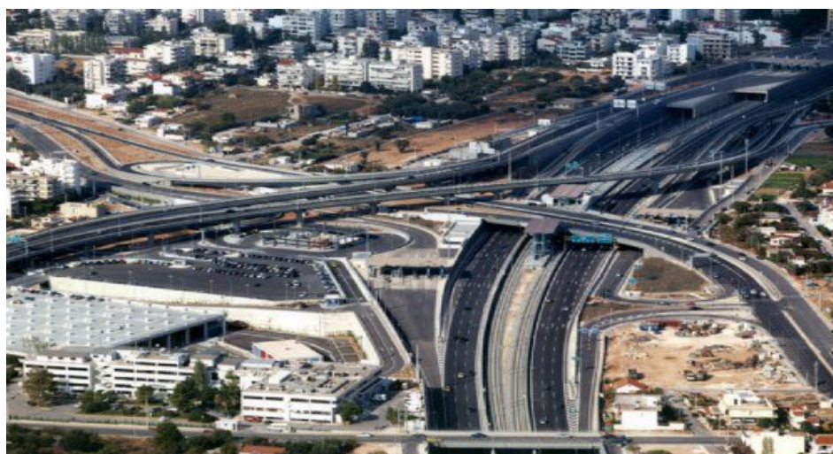
3.7. Φωτογραφία Αττικής Οδού Πηγή: Αττική Οδός
