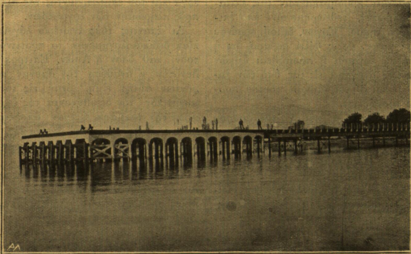
Σχῆμα 1.—Ἀποβάθρα Ἁγίας Μαρίνης διὰ σιδηροπαγοῦς σκιροκονιάματος.
