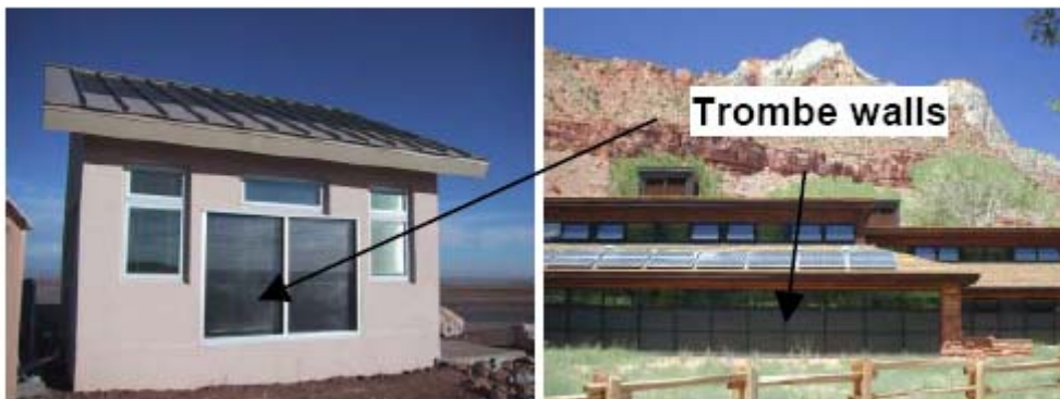
Εικόνα 25: Εφαρμογές τοίχου Trombe σε κτίρια χαμηλής ενέργειας [61]
