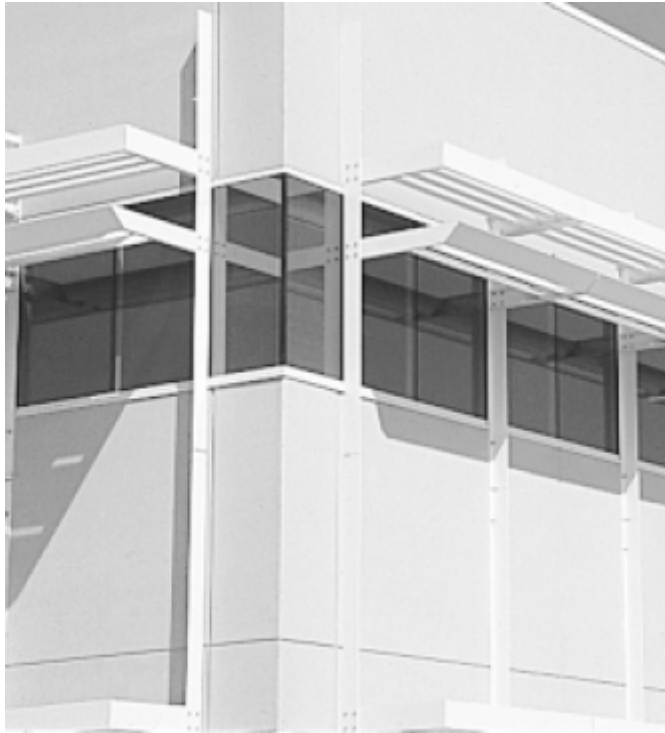
Εικόνα 43: Όριζόντιες εξωτερικές περσίδες, κατάλληλες για νότιο προσανατολισμό. Λειτουργούν αποδοτικά, εκτός από τις γωνίες. Διπλή σειρά περσίδων έχει χρησιμοποιηθεί [66]
