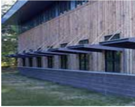
Εικόνα 88: Εξωτερικά ράφια φωτισμού
