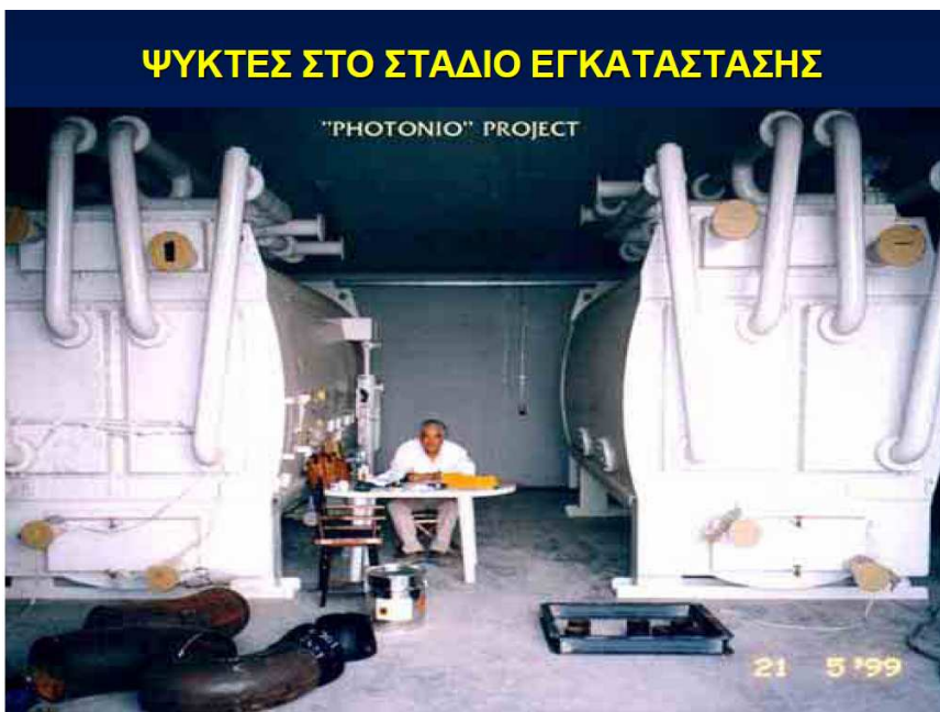
Εικόνα 3 : Ψύκτες στο στάδιο της εγκατάστασης στο έργο "Φωτόνιο" της επιχείρησης Σαράντης στα Οινόφυτα.
