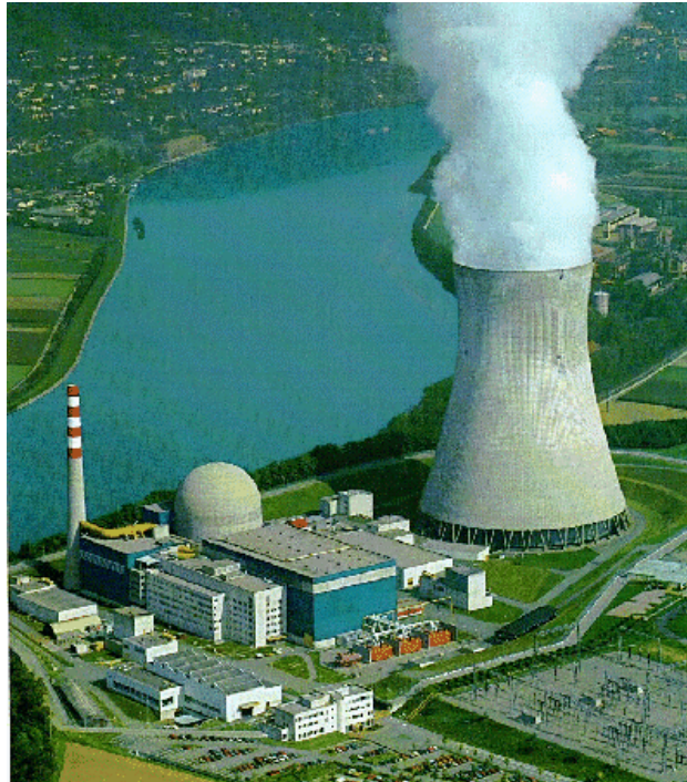
Σχήμα 2.11: Υγρός πύργος ψύξης [17]
