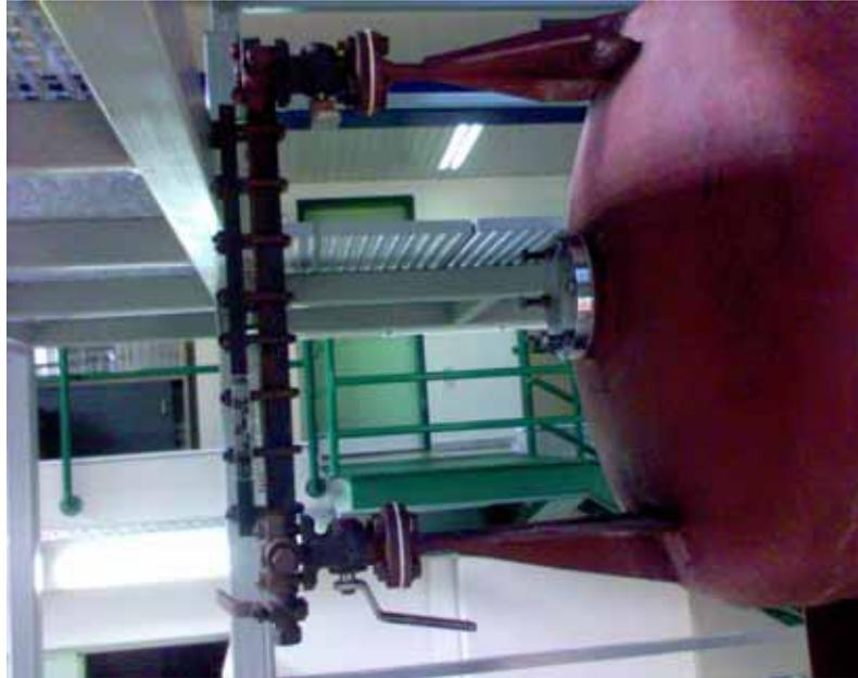
Σχήμα 2-5: Πλάγια όψη του δοχείου βρασμού.
