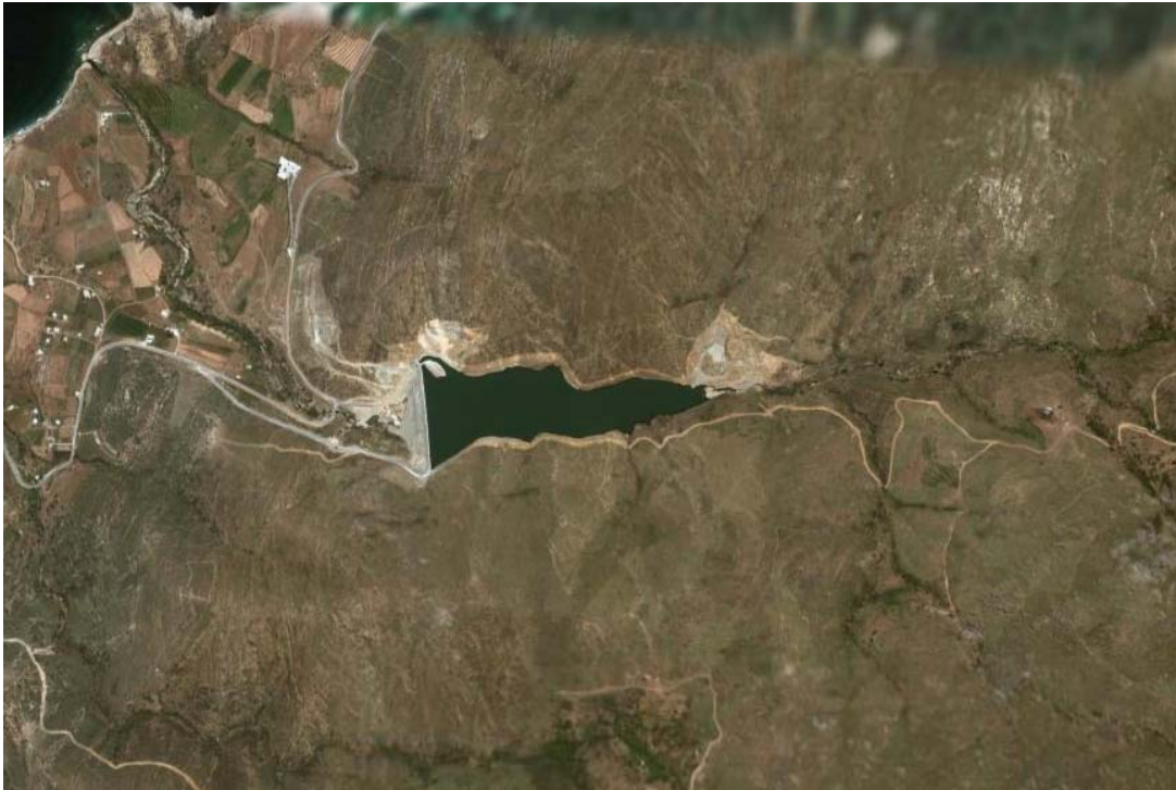
Σχήμα 2.15. Φράγμα Τσικαλαρριού Νάξου.
