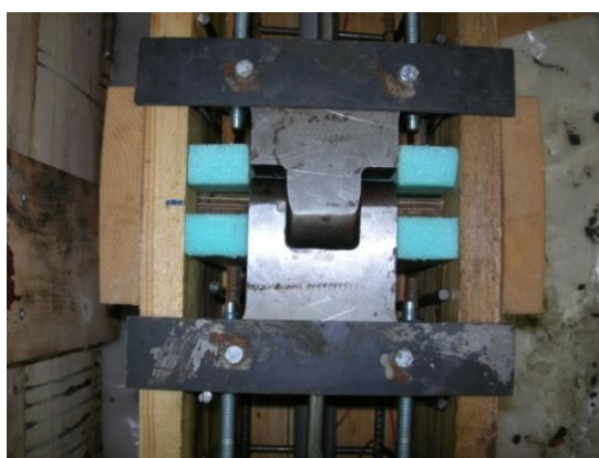
Σχήμα 2.2 - Η μεταλλική άρθρωση τοποθετημένη στο καλούπι.
